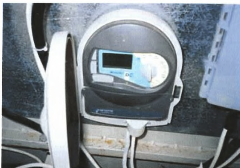
Εικόνα 3.8 Προγραμματιστής (Miracle DG) της εταιρείας Netafim.
