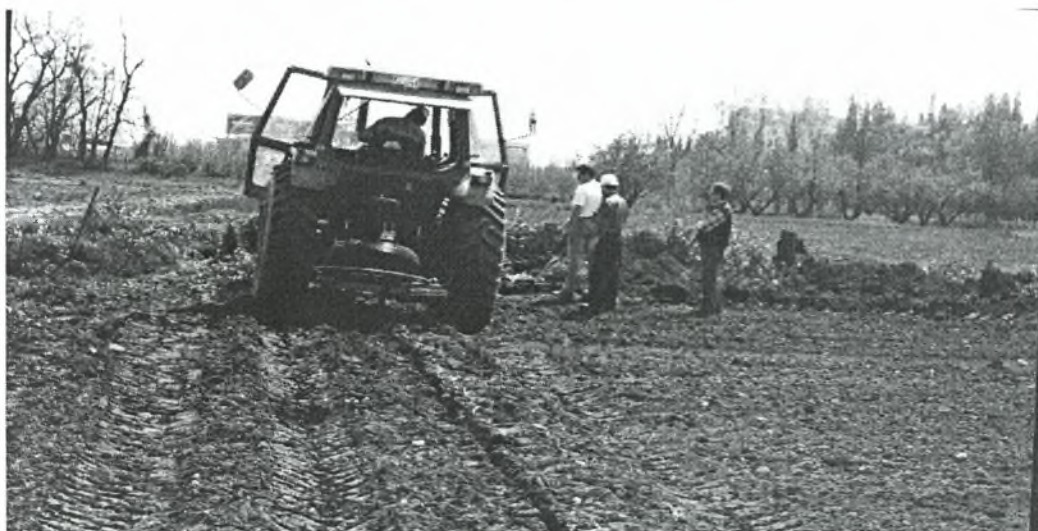
Εικόνα 4.5 Τοποθέτηση υπόγειου δικτύου άρδευσης.
