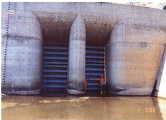
Εικόνα 9 : Η έμφραξη της σήραγγας εκτροπής με το κατέβασμα των χαλύβδινων θυρών (υψόμετρο 294 m). Τα νερά των ποταμών έχουν ήδη αρχίσει να συγκεντρώνονται σχηματίζοντας την λίμνη (1/7/2002).
