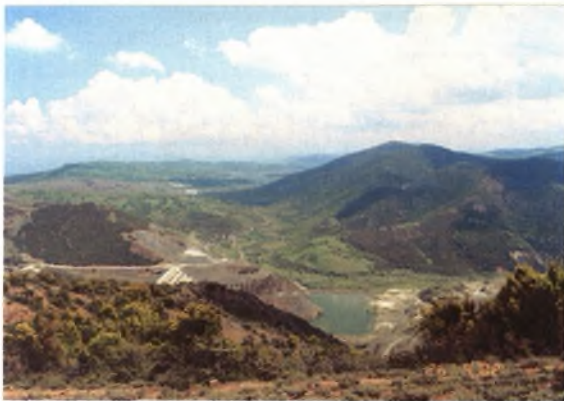
Εικόνα 7 : Άποψη της περιοχής πριν την έμφραξη. Φαίνονται το πρόφραγμα που δημιουργήθηκε για να συγκρατεί τα νερά των δύο ποταμών, ώστε να είναι δυνατή η κατασκευή του φράγματος (26/04/2002).
