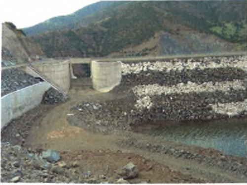
Εικόνα 18 : Περιοχή φράγματος. Το νερό έχει φθάσει στα 367 m. Η υπερχείλιση του φράγματος που διακρίνεται αριστερά βρίσκεται στα 375 m (25/05/2004).
