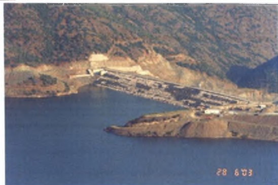
Εικόνα 17 : Περιοχή φράγματος, ένα χρόνο αργότερα. Ο ταμιευτήρας σχηματίσθηκε μετά τις πολλές βροχές του προηγούμενου χειμώνα. Αριστερά, στην άκρη του φράγματος φαίνεται η υπερχειλίση. Προβλέπεται μόνιμη παροχή 2 m 3 /s νερού το καλοκαίρι, για οικολογικούς σκοπούς (28/06/2003).
