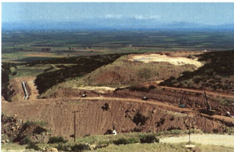
Εικόνα 112 : Τροφοδοτικός αγωγός Φ800. Στο βάθος μεγάλο τμήμα του θεσσαλικού κάμπου (Σπυριδώνης Ι., τοπογράφος-μηχανικός)
