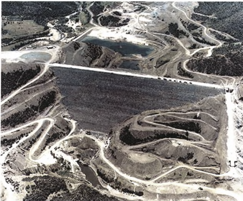
Εικόνα 4: Το φράγμα και μέρος του ταμιευτήρα της τεχνητής λίμνης Σμοκόβο μετά την ολοκλήρωση της κατασκευής τους ( www.empedos.gr ).
