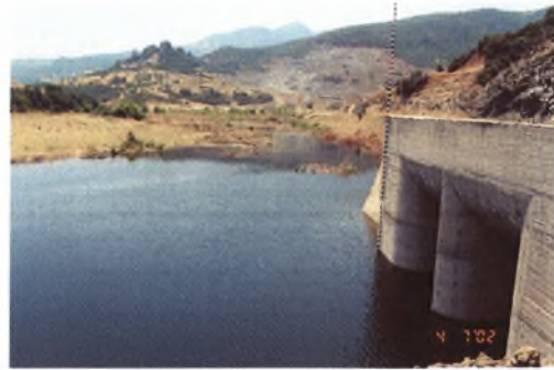
Εικόνες 13 και 14 : Τρεις μέρες αργότερα αρχίζει να σχηματίζεται ο ταμιευτήρας. Στην δεξιά φωτογραφία, διακρίνεται η στήλη μέτρησης της στάθμης του νερού (4/7/2002).
