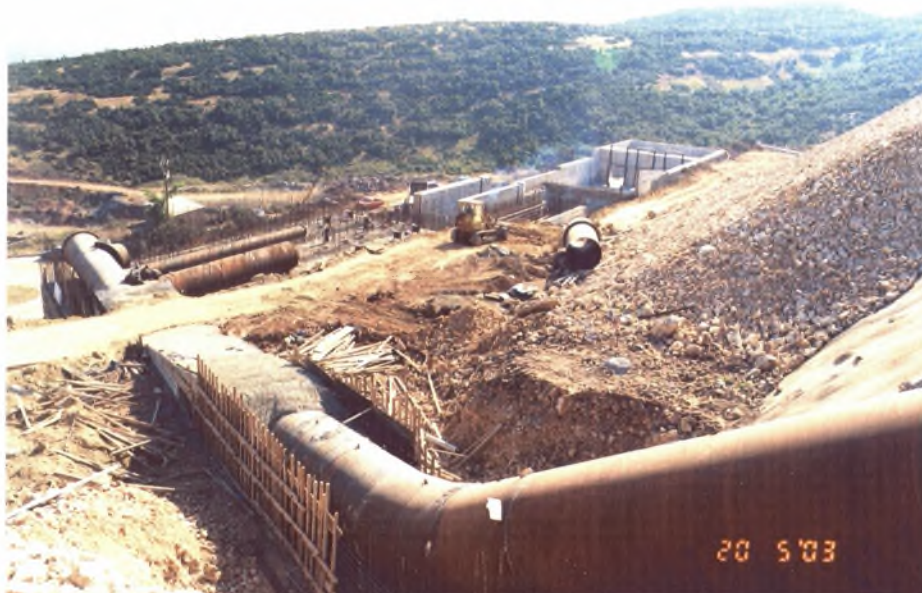
Εικόνα 115 : Από την κατασκευή της σήραγγας Λεονταρίου (Σπυριδώνης Ι., τοπογράφος-μηχανικός).
