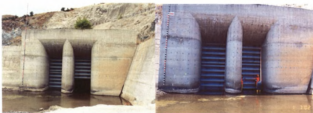
Εικόνα 36: Τα θυροφράγματα πριν και μετά την έμφραξη (Σπυριδώνης Ι., τοπογράφος-μηχανικός).
