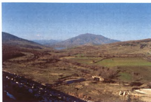
Εικόνα 33 : Η γέφυρα Κτιμένης πριν την κατασκευή του αναχώματος προσπέλασης (φωτ. Σπυριδώνης Ι., τοπογράφος-μηχανικός).
