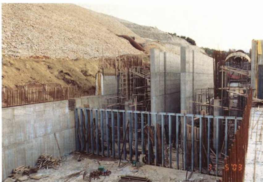
Εικόνα 40 : Από την κατασκευή του Έργου Καταστροφής Ενέργειας (Σπυριδώνης Ι., τοπογράφος-μηχανικός).
