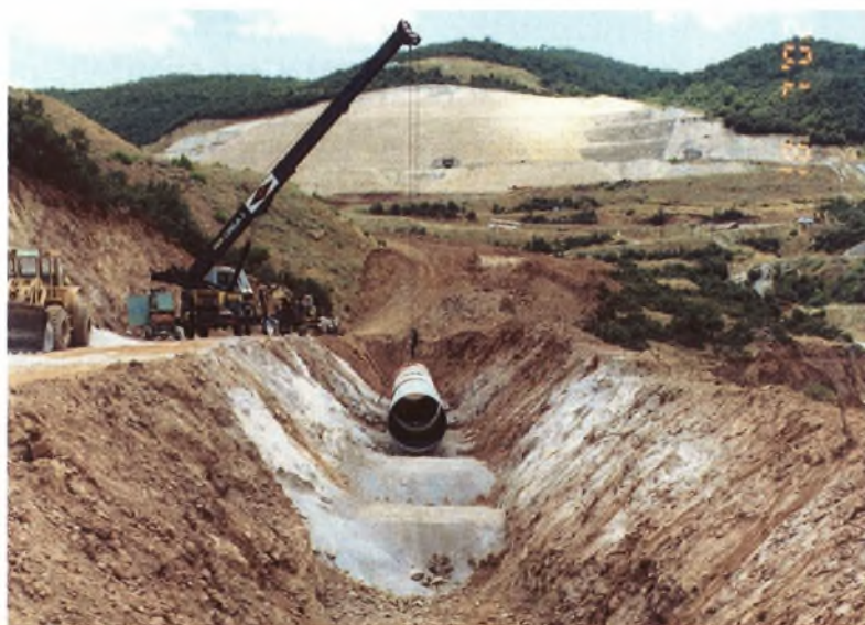
Εικόνα 114: Από Τοποθέτηση Αγωγού Φ 180 (Σπυριδώνης Ι., τοπογράφος-μηχανικός).
