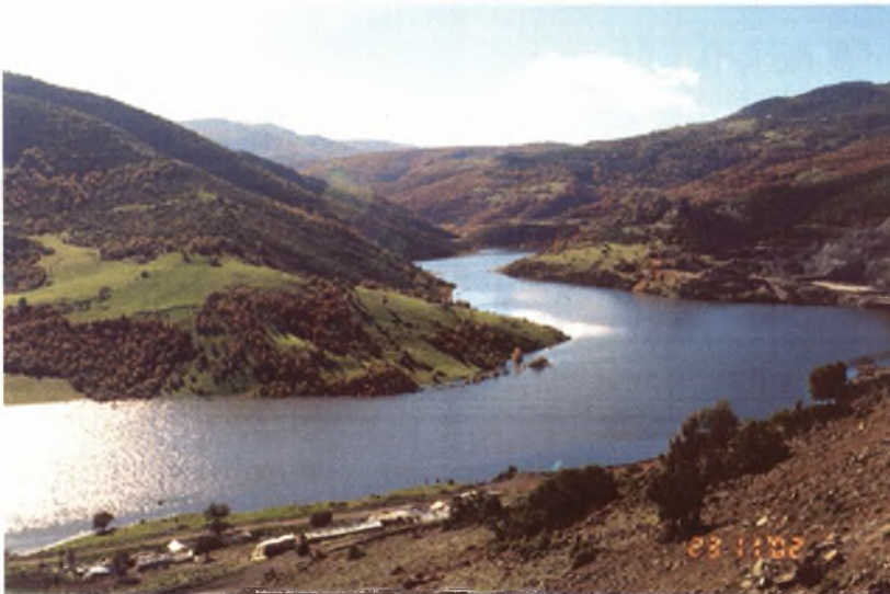
Εικόνες 10, 11 και 12 : Τρεις φωτογραφίες που λήφθηκαν από το ίδιο σημείο σε διαφορετικές χρονικές στιγμές (29/06/02, 02/10/02 και 22/11/02), που δείχνουν σταδιακά τη διαδικασία εμπλουτισμού του ταμιευτήρα.
