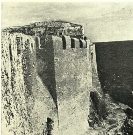
Μονεμβασία: α - β. Τμήμα παρά την μικράν πύλην κατά τήν στερέωσιν καί μετά ταύτην, γ. Τò στερεωθὲν παρά τήν θέσιν «Πορτέλο» τμήμα τῶν τειχῶν μέ τὰς ὀδοντωτάς ἀπολήξεις, δ. Στερέωσις ὀδοντωτῶν ἀπολήξεων τῶν τειχῶν
