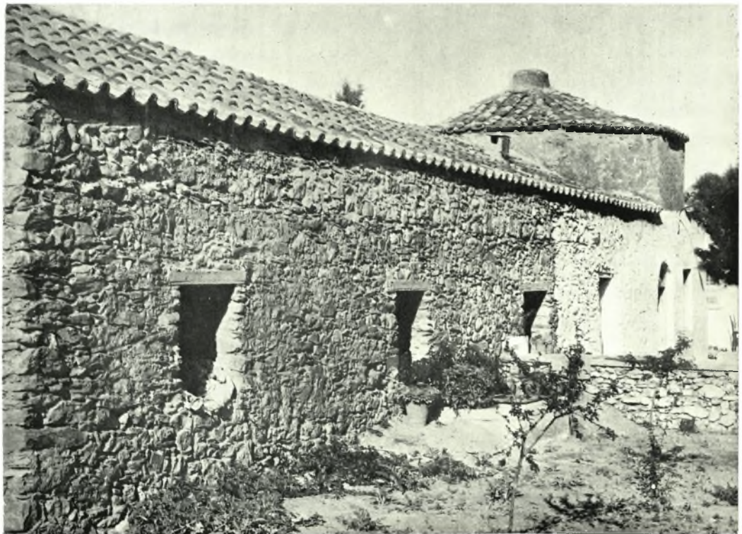
Ἄττική. Ἅγιος Ἰωάννης ὁ Θεολόγος: α. Ἡ καμάρη τῆς Τραπεζῆς κατὰ τὰς ἐργασίας ἀποκαταστάσεως, β. Ἡ Τράπεζα τῆς Μονῆς μετὰ τὴν ἀποκατάστασιν τῆς στέγης Π. ΛΑΖΑΡΙΔΗΣ
