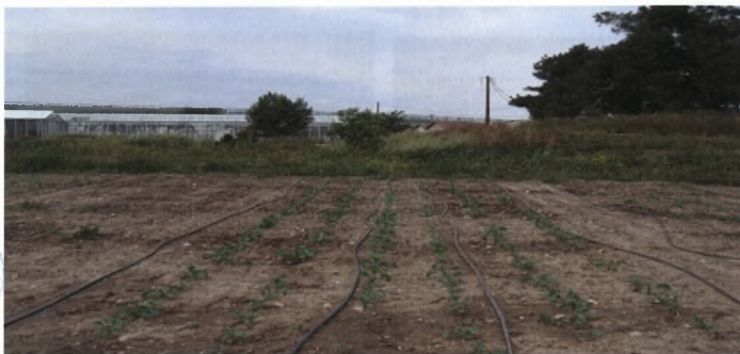
Εικόνα 4.7 Εγκατάσταση επιφανειακού δικτύου άρδευσης
