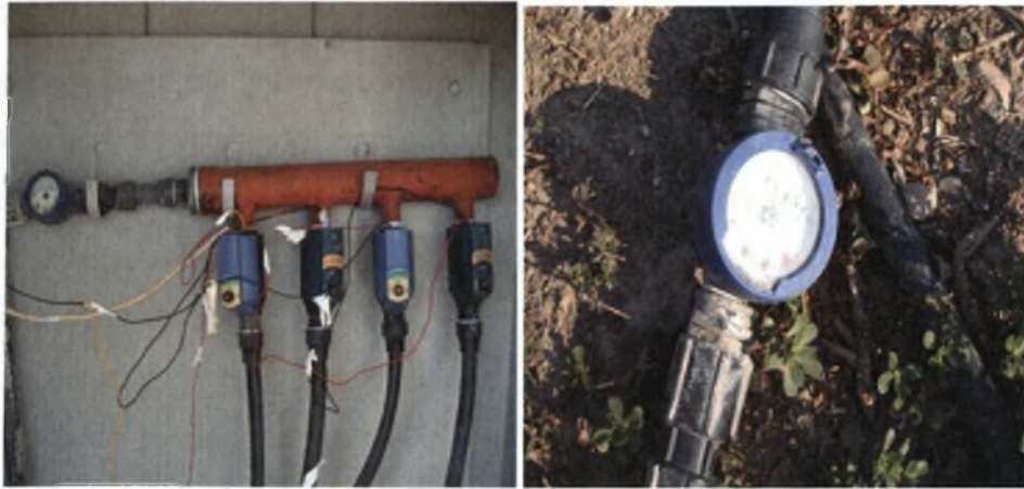
(α) (β) Εικόνα 4.8 Ηλεκτροβάνες (α) και υδρόμετρο (β).
