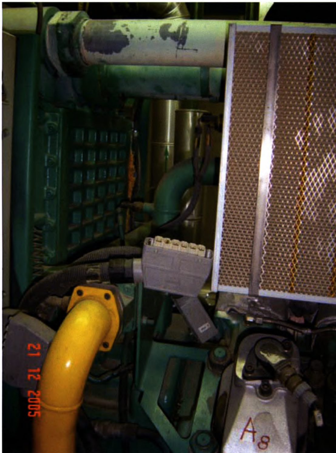
Φωτογραφία 3.2 : Σύστημα μίξης αερα-καυσιμου (κουτι με δικτυωτο πλεγμα ενω φαινεται και ο κυλινδρος α8 απο τη μια πλευρα της μηχανης
