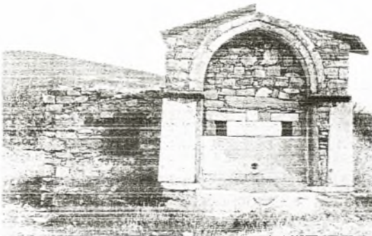
61. Περιοχή Κοκκίνας. Κρήνη με εντοιχισμένο αρχαίο υλικό
