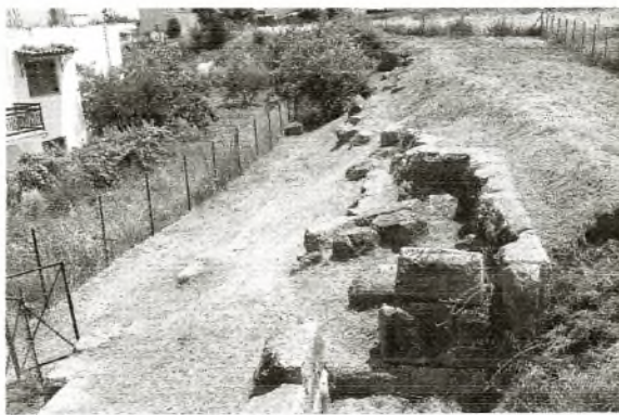
87. Φερές. Τμήμα τείχους της κλασικής περιόδου
