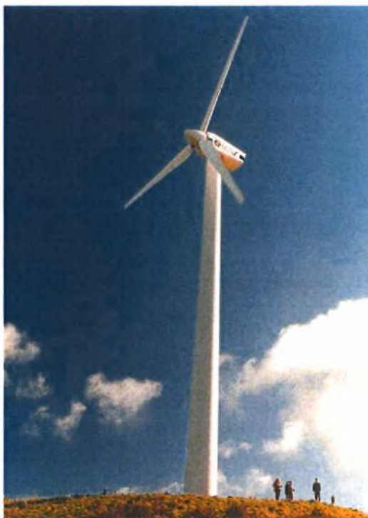
Εικόνα 1.1: Ανεμογεννήτρια οριζόντιου άξονα
