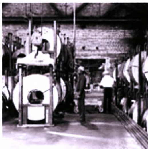
Εικόνα 4.13 Εφαρμογή διάταξης σε βιομηχανικό χώρο
