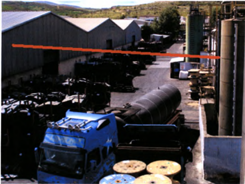
Εικόνα 4.3 Σημεία εγκατάστασης γερανογέφυρας (αποθήκη 1- Ζυμωτήριο)
