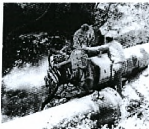
Εικόνα Ε8: Τοποθέτηση αγωγού φυσικού αερίου
