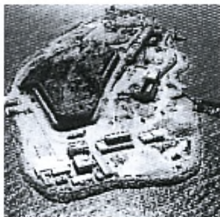
Σχήμα 2.6: Σταθμός υγροποιημένου φυσικού αερίου στην Ρεβυθούσα (ΔΕΠΑ) [10]
