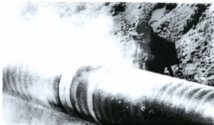
Εικόνα Ε7: Αμμοβολή αγωγού φυσικού αερίου
