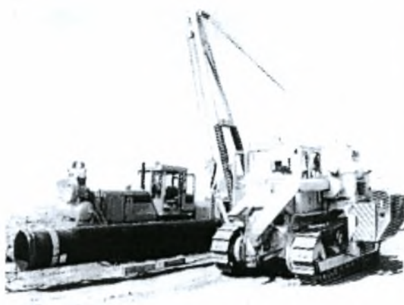
Εικόνα Ε8: Τοποθέτηση αγωγού φυσικού αερίου
