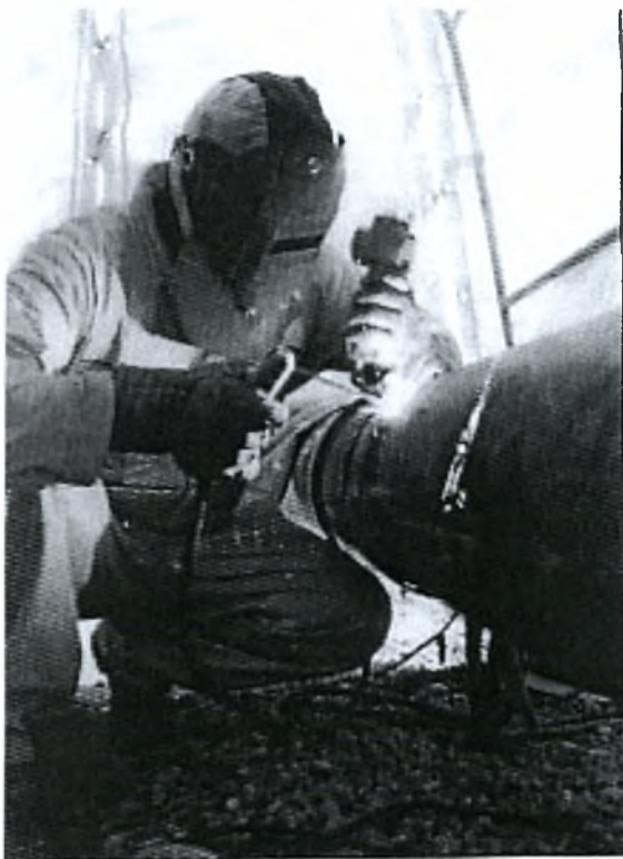
Εικόνα Ε6: Συγκόλληση αγωγού φυσικού αερίου
