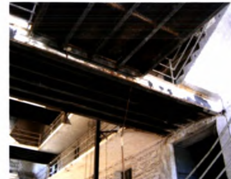
Μεταλλικό προστατευτικό πλαίσιο και πίσω ξύλινα κουφώματα στο ύψος των ορόφων α' και β' της καπναποθήκης (αρχείο συντάκτριας, 16/12/2007)
