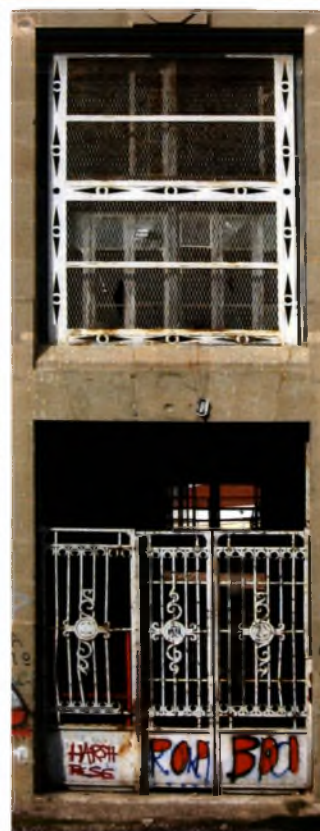
Μεταλλικό προστατευτικό πλαίσιο και πίσω ξύλινα κουφώματα στο ύψος των ορόφων α' και β' της καπναποθήκης (αρχείο συντάκτριας, 16/12/2007)
