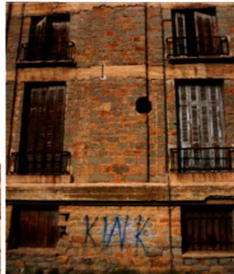
Κατασκευαστικά στοιχεία: σωλήνες ύδρευσης ως προστατευτικά κιγκλιδώματα, οπτοπλινθοδομή, τσιμεντένιο σενάζ, μεταλλικά ελάσματα δεσίματος τοιχοποιίας, αεραγωγοί και κουφώματα ξύλινα γαλλικά με μπαλκόνι από σφυριλατημένο σίδηρο (αρχείο συντάκτριας, 16/12/2007)
