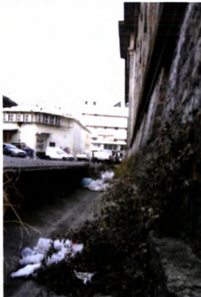
Τσιμεντένια υδρορροή που διατρέχει περιμετρικά το κτίριο (αρχείο συντάκτριας, 4/5/2008)
