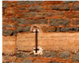
Κατασκευαστικά στοιχεία: σωλήνες ύδρευσης ως προστατευτικά κιγκλιδώματα, οπτοπλινθοδομή, τσιμεντένιο σενάζ, μεταλλικά ελάσματα δεσίματος τοιχοποιίας, αεραγωγοί και κουφώματα ξύλινα γαλλικά με μπαλκόνι από σφυριλατημένο σίδηρο (αρχείο συντάκτριας, 16/12/2007)
