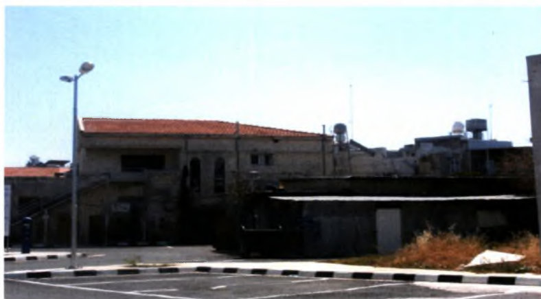
Φωτογραφία 60: Τούρκικη Λέσχη σε αχρησία επί της οδού Φελλάχογλου Πηγή: Προσωπικό αρχείο
