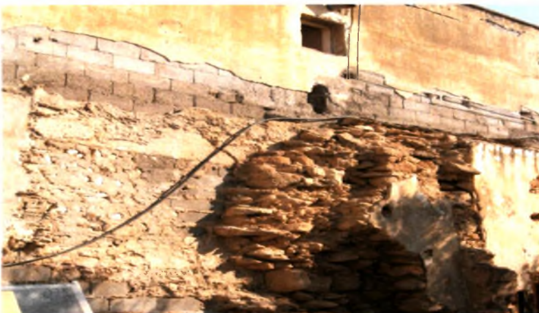
Φωτογραφία 36: Κτίριο σε καλή κατάσταση στο δυτικό τμήμα του παραδοσιακού πυρήνα – (ανεπίχρηστες τοιχοποιίες)
