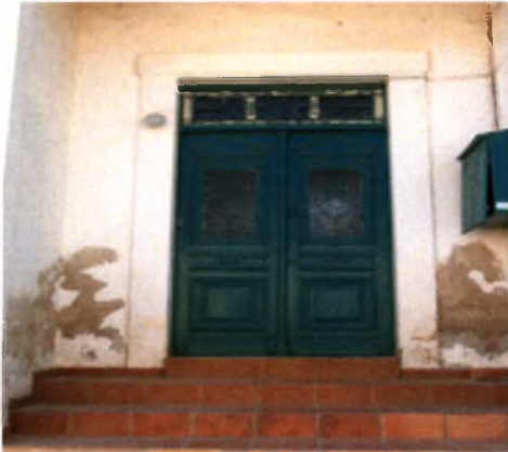
Φωτογραφία 56: Νεοκλασική θύρα σε υποχώρηση από το δρόμο Πηγή: Προσωπικό αρχείο
