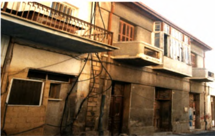
Φωτογραφία 38: Ενδεικτικό παράδειγμα της παρουσίας των αιωρούμενων καλωδίων.
