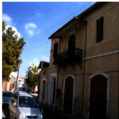
Φωτογραφία 59: Διατηρητέο κτίριο στην οδό Kemal Atattourk: Πηγή: Προσωπικό Αρχείο
