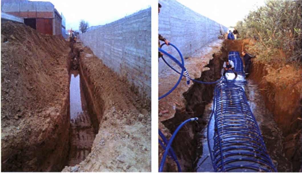
Σχήμα 5.2 : Εκσκαφή και τοποθέτηση Slinky
