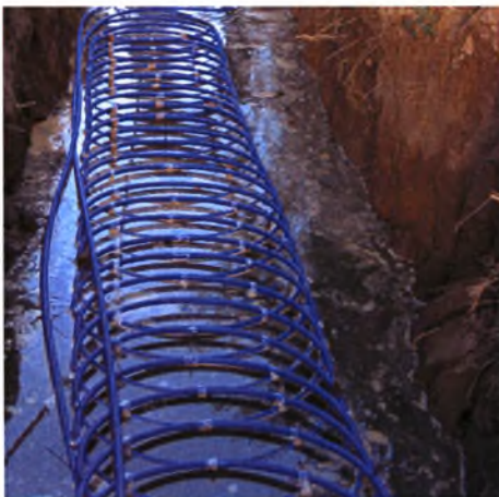
Σχήμα 2.6: Σπειροειδές σύστημα-οριζόντια διάταξη
