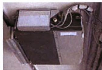
Σχήμα 3.6: Εσωτερικά μηχανήματα κρυφού τύπου οροφής εγκατάστασης VRF
