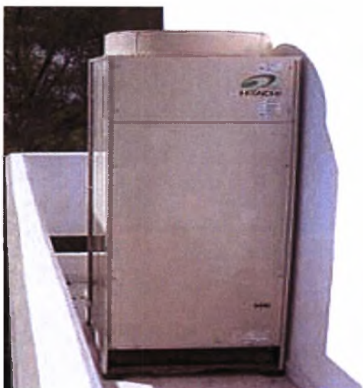
Σχήμα 3.4: αερόψυκτη αντλία θερμότητας VRV - VRF
