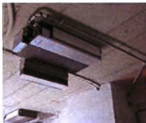
Σχήμα 3.6: Εσωτερικά μηχανήματα κρυφού τύπου οροφής εγκατάστασης VRF
