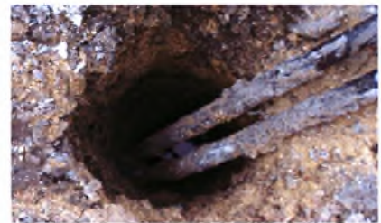
Σχήμα 2.13: Τοποθέτηση γεωεναλλάκτη στην γεώτρηση
