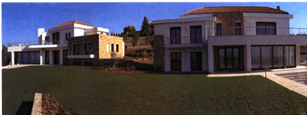
Σχήμα 1.2: μονοκατοικίες στις οποίες εγκαταστάθηκαν γεωθερμικά συστήματα τύπος συστήματος: 2 κατακόρυφα κλειστά κυκλώματα γεωεναλλάκτη συνολική θερμική ισχύς (kW): 2 \times (2 \times 12) = 48\text{kW}
