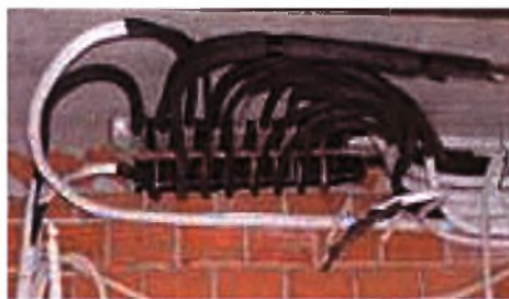
Σχήμα 3.5: συλλέκτης διανομής ψυκτικού υγρού freon .
