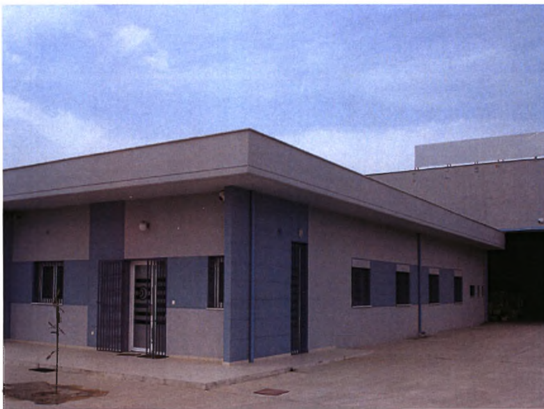
Σχήμα 1.1: Κτίριο γραφείων στο οποίο εγκαταστάθηκε γεωθερμική αντλία θερμότητας VRV
