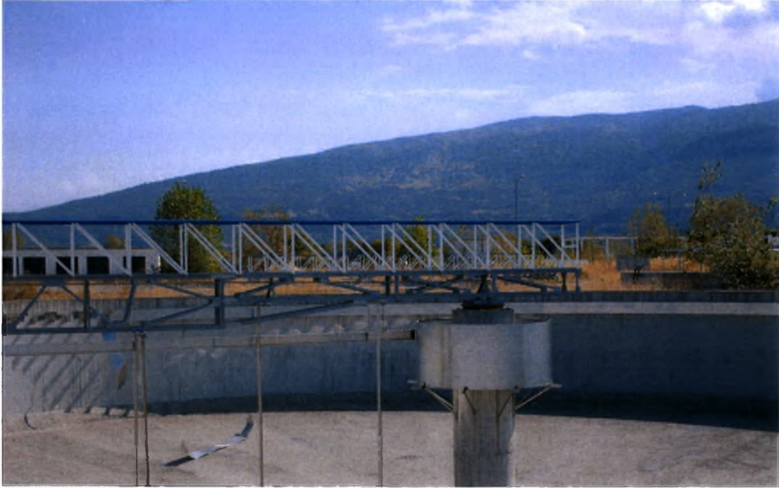
Εικόνα 5: ΕΕΛ Κορινού (Δεξαμενή δευτεροβάθμιας επεξεργασίας)
