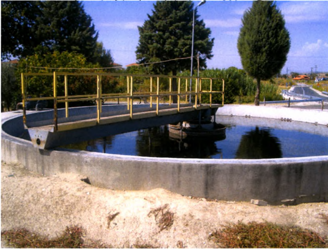
Εικόνα 3: ΕΕΛ Κοлиндρού (Δεξαμενή πρωτοβάθμιας επεξεργασίας)
