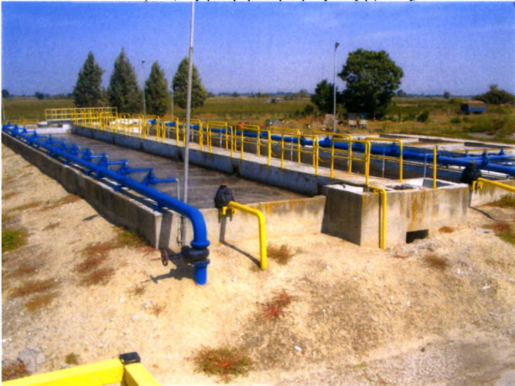
Εικόνα 3: ΕΕΛ Κοлиндρού (Δεξαμενή πρωτοβάθμιας επεξεργασίας)
