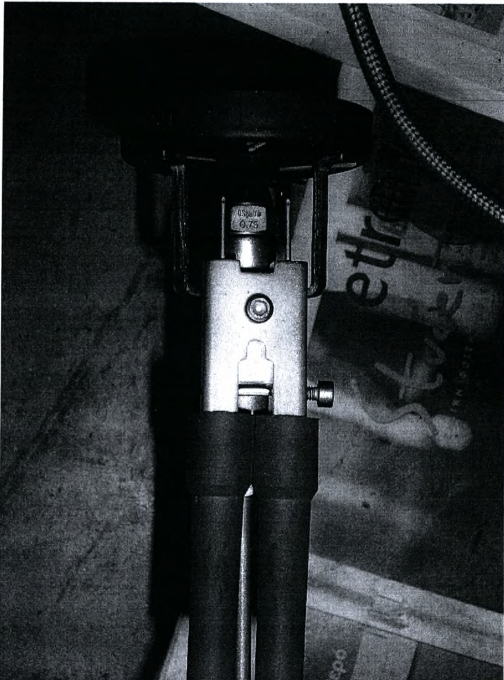
Εικόνα 10 Η διάταξη έναυσης του καυστήρα δίπλα στο μπέκ
