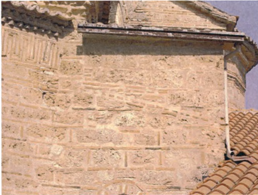
Εικ. 18 Μετέωρα, Μονή Μεγάλου Μετεώρου, παλαιό καθολικό. Λεπτομέρεια της τοιχοποιίας του ανατολικού τοίχου.
