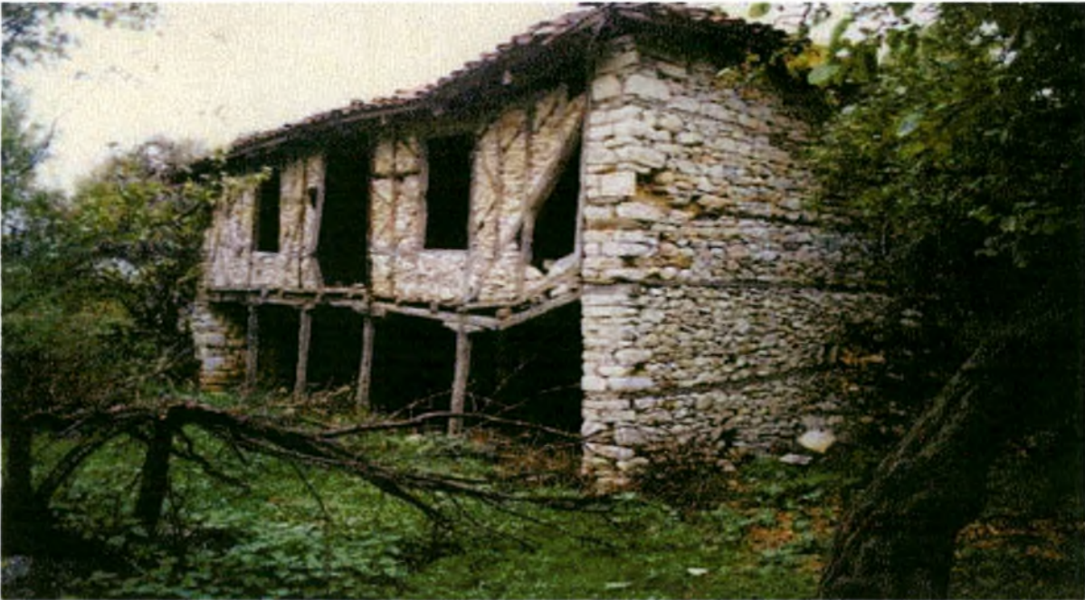
Εικόνα 1 : Σπίτι στο Καλό Νερό. Η πρόσοψη του είναι φτιαγμένη με τσατμά (ξύλινο σκελετό τα κενά του οποίου γεμίζονται με πέτρες).
