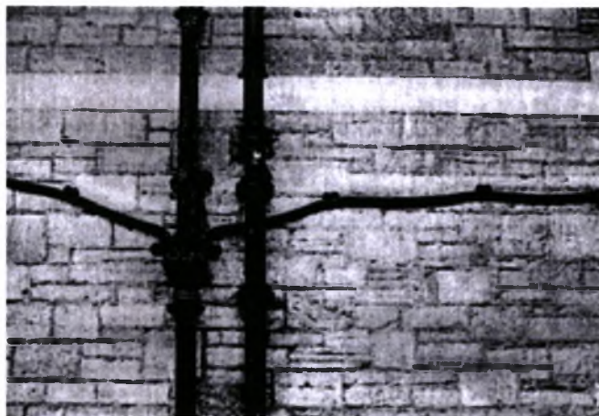
Σχ 1.4 Οι σωλήνες μολύβδου παραμορφώνονται κατά τη διάρκεια των ετών λόγω του ερπυσμού.
