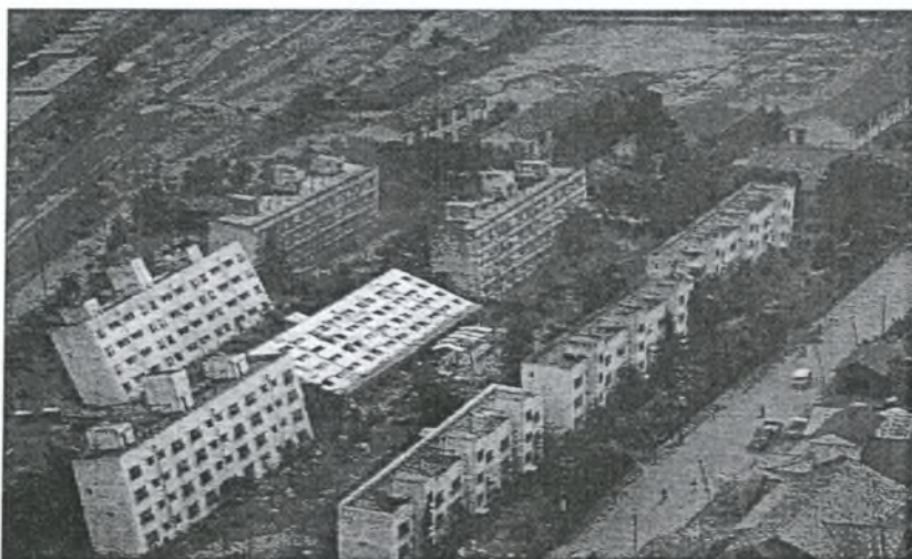
Εικόνα 1.1 Ρευστοποίηση του εδάφους στην πόλη Νιγκάτα από τον καταστροφικό σεισμό του 1964
