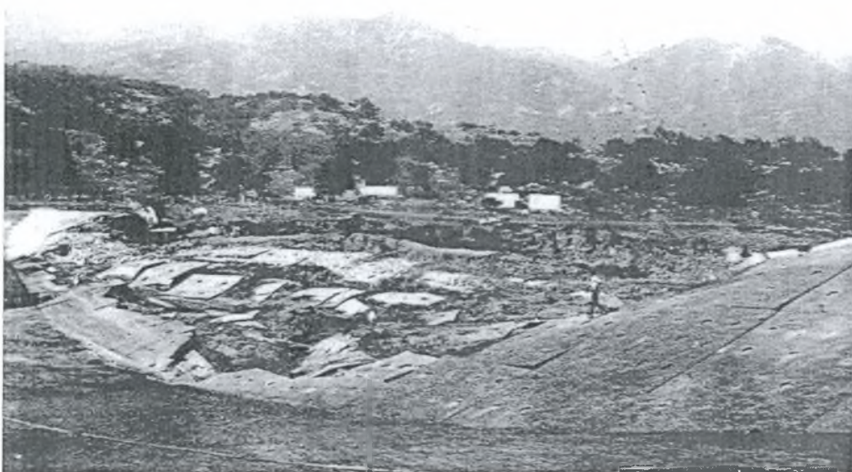
Εικόνα 1.5: Καταστροφή φράγματος του Σέφιλντ κατά τον σεισμό Santa Barbara το 1925
