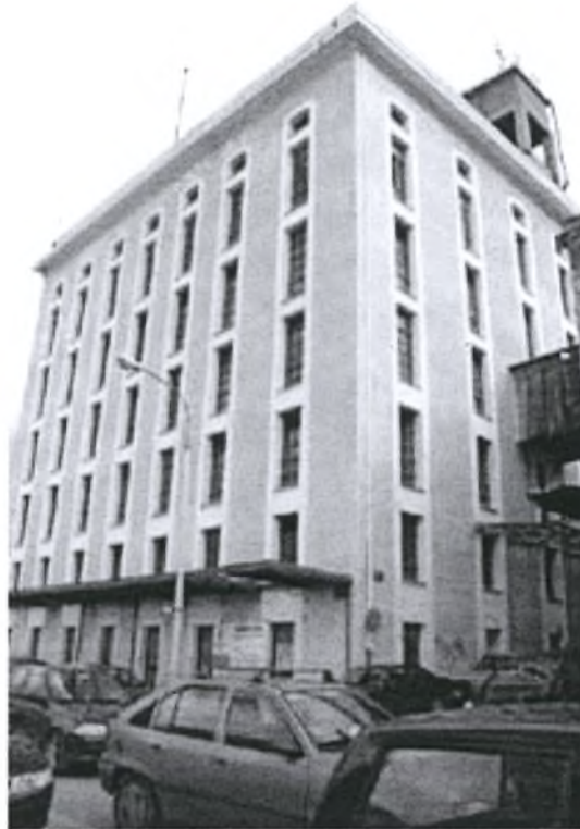
Εικόνα 5.8: Το ανακατασκευασμένο κτίριο της αλευροβιομηχανίας «Μύλοι Αγίου Γεωργίου». (Πηγή: www.patras2006.gr )
