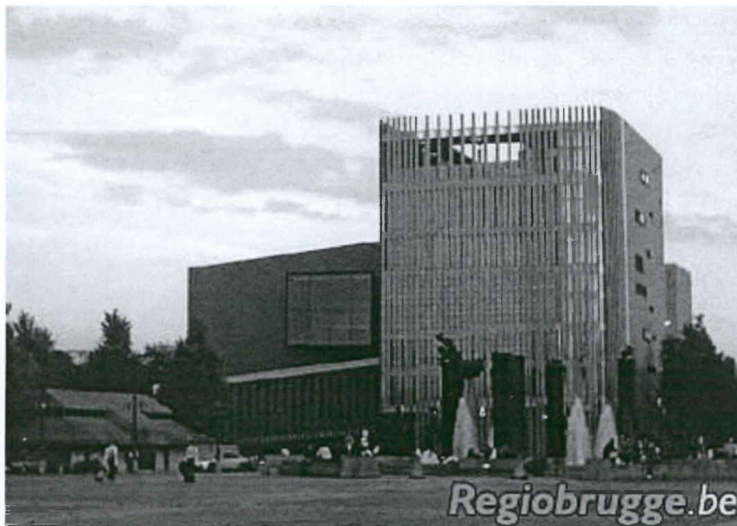
Εικόνα 3.21: Η Concertgebouw στη Μπριζ. (Πηγή: www.google.gr )
