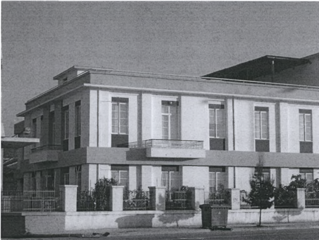
Εικόνα 5.4: Τα ανακατασκευασμένα κτίρια της χαρτοβιομηχανίας Λαδόπουλου. (Πηγή: Ιδία επεξεργασία)
