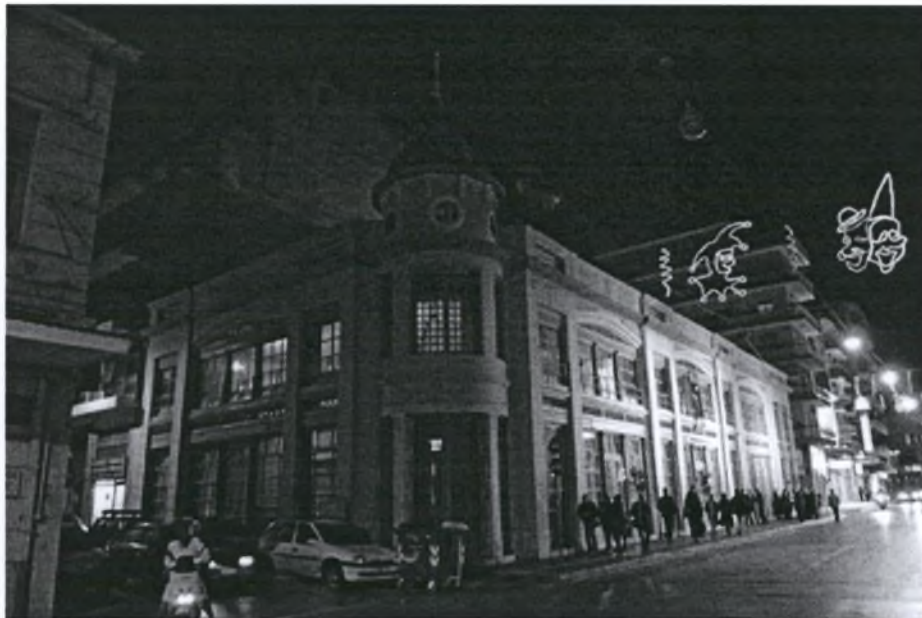
Εικόνα 5.7: Το κτίριο της βιομηχανίας του Μαραγκόπουλου. (Πηγή: www.patras2006.gr )
