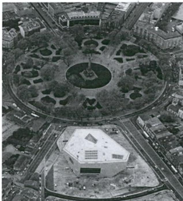
Εικόνα 3.19: Το Casa da Musica και ο περιβάλλον χώρος του. (Πηγή: www.google.gr )
