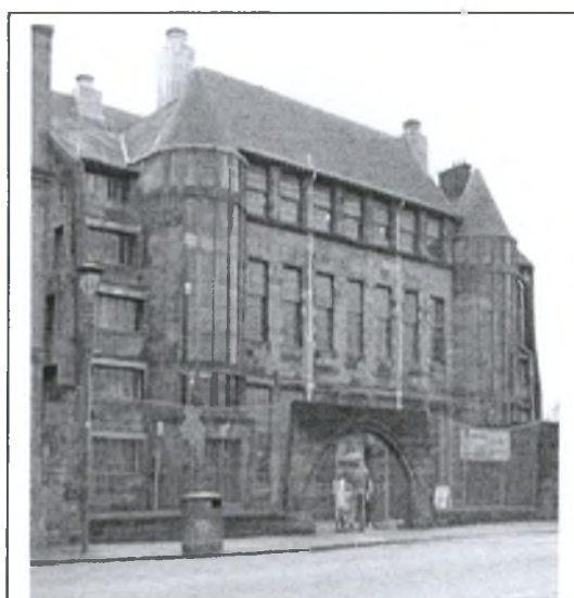
Εικόνα 3.4: Το Scotland Street School στη Γλασκόβη. (Πηγή: www.google.gr )
