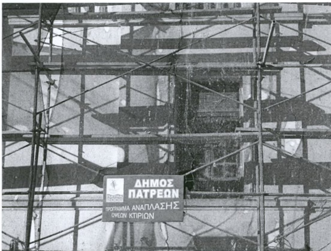
Εικόνα 5.14: Εργασίες ανάπλασης σε κτίριο της οδού 25 ης Μαρτίου. (Πηγή: Ιδία επεξεργασία)
