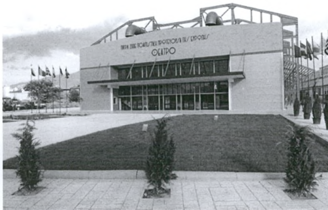
Εικόνα 5.9: Το προκατασκευασμένο θέατρο πλησίον της χαρτοβιομηχανίας Λαδόπουλου. (Πηγή: www.patras2006.gr )
