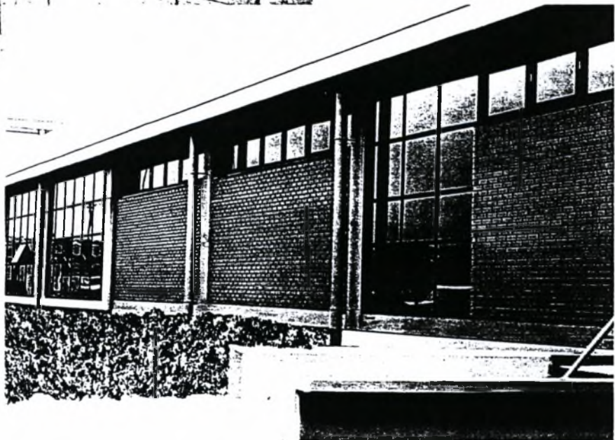
Εφαρμογή εμφανούς πλίνθου ολοκλήρου στο Πλεκτήριο ΣΙΣΕΡ ΠΑΛΛΑΣ ΕΠΕ, Κομοτηνή
