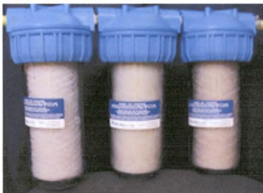
Σχήμα 3-5: Φίλτρα των 25 \mu\text{m} , 5 \mu\text{m} και 2 \mu\text{m}
