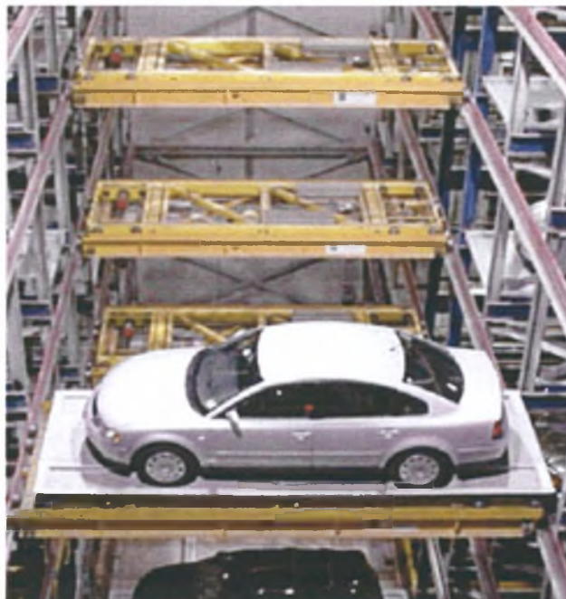
Εικόνα 2: Ανελκυστήρες και παλέτα μεταφοράς οχημάτων στο garage του Hoboken [16].
