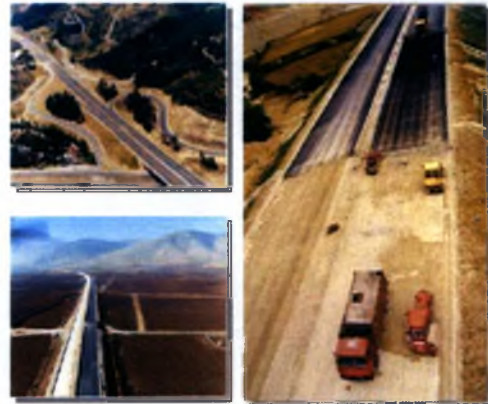
Εικόνα 2.7: Η Εγνατία Οδός κατά την κατασκευή
