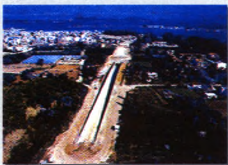
Εικόνα 5.8: Η ζεύξη Ακτίου-Πρέβεζας
