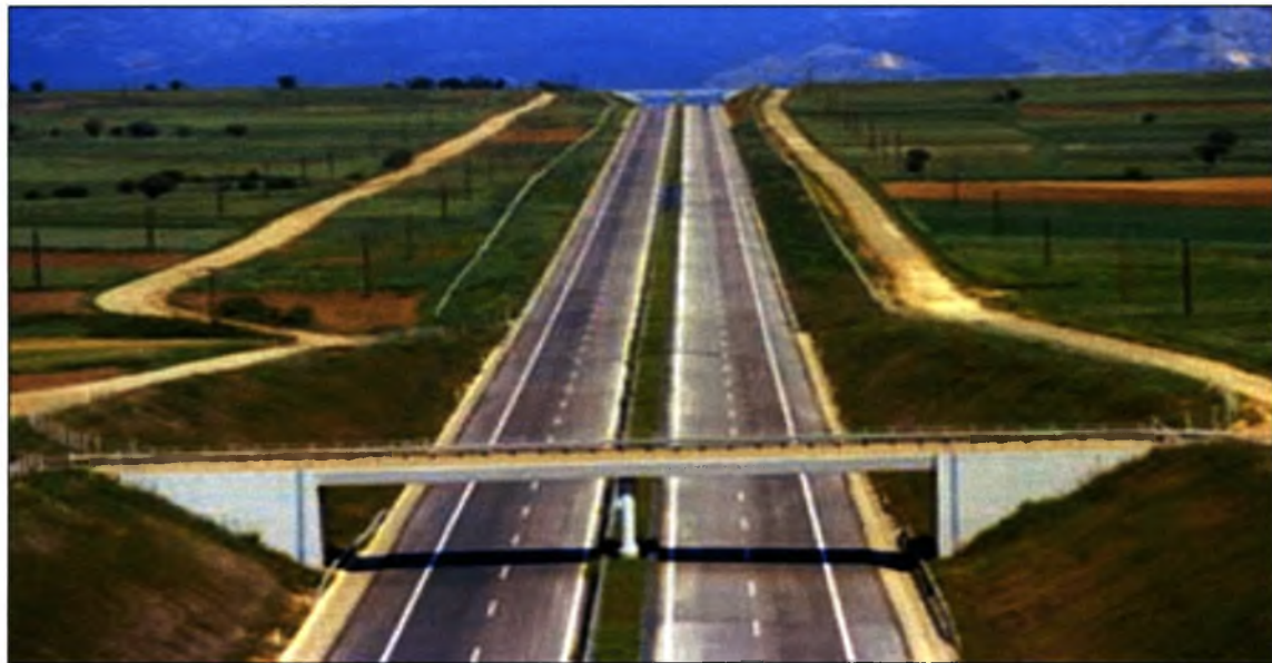
Εικόνα 5.3: Εγνατία Οδός: Τμήμα Στρώμη-Κομοτηνή
