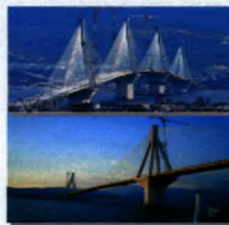
Εικόνα 3.5: Η ζεύξη Ρίου-Αντιρρίου
