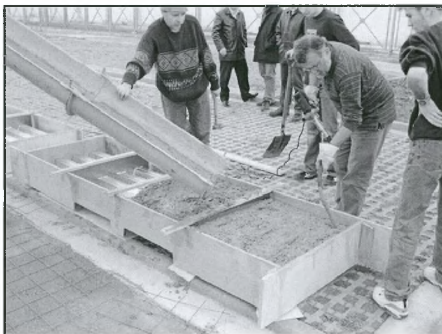
Σχήμα 3.1.2 Χρήση ηλεκτρικού δονητή για την αποτελεσματικότερη διάστρωση του σκυροδέματος.
