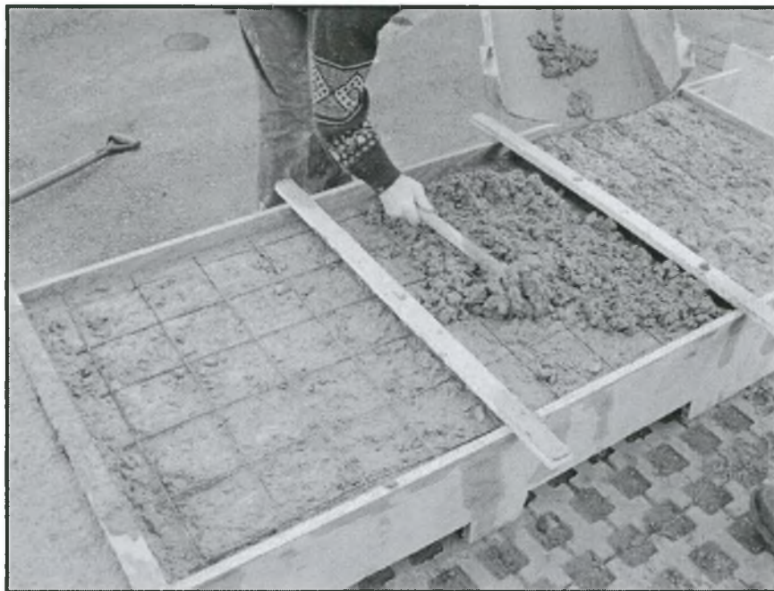
Σχήμα 3.1.3 Τοποθέτηση πλέγματος οπλισμού στο πάνω μέρος της πλάκας.
