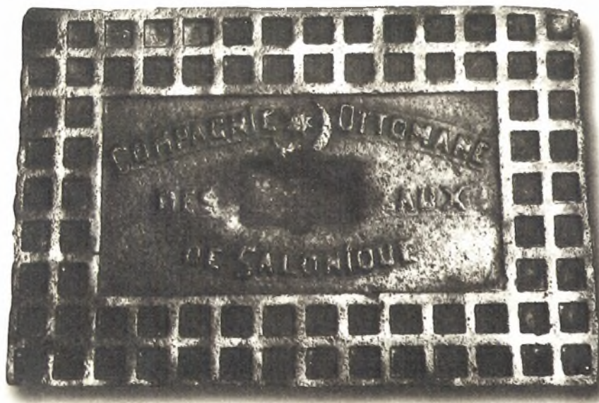
Εικόνα 4.1. Καπάκι φρεατίου δικλείδας πυρκαγιάς (1890)
