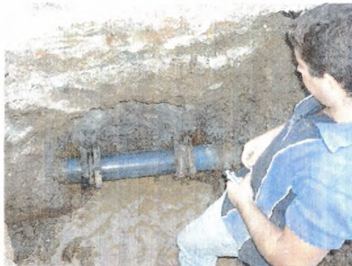
Εικόνα 3.1. Επισκευή θραύσης με την μέθοδο των ζιμπώ
