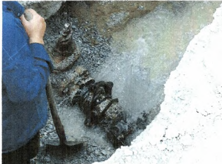
Εικόνα 3.3. Επισκευή διαρροής [Πηγή : Αρχεία Ε.Υ.Α.Θ.]
