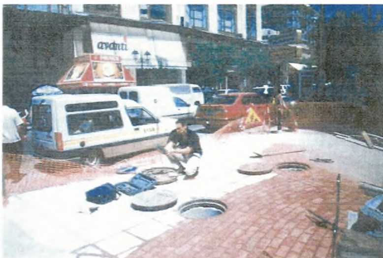
Εικόνα 6.1. Ολοκλήρωση φρεατίου και παρακολούθηση μειωτή πίεσης στη Βενιζέλου [Πηγή : Αρχεία Ε.Υ.Α.Θ.]
