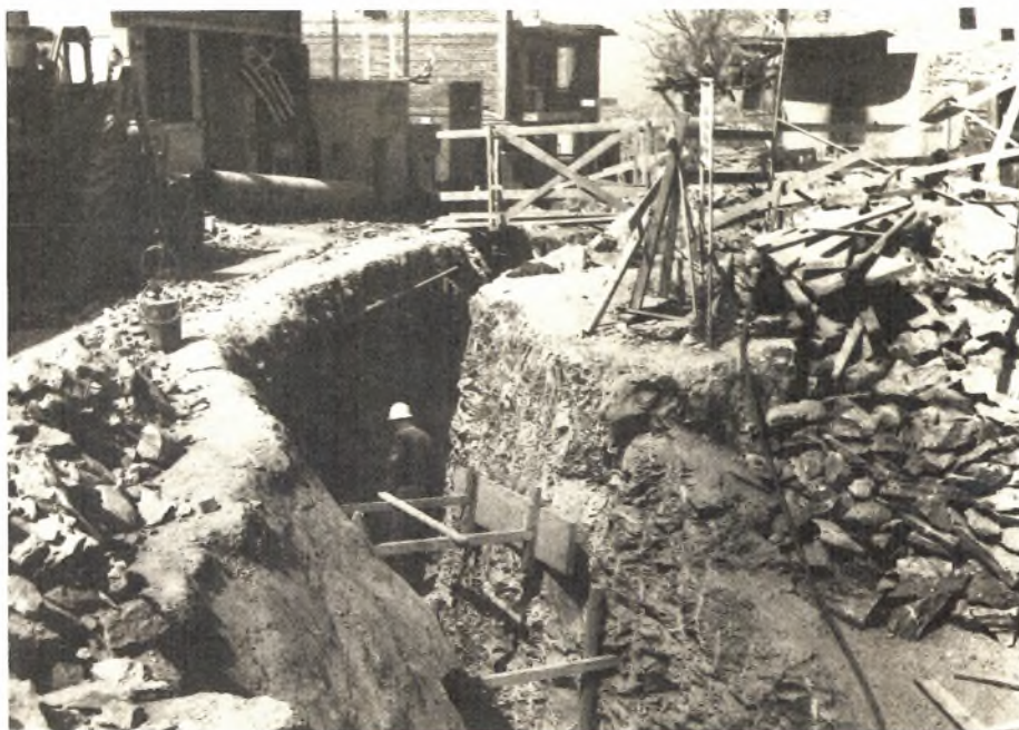
Εικόνα 3.2. Εγκατάσταση αγωγού μέσα στην πόλη (1960)
