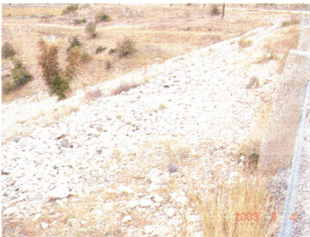
Στη φωτογραφία φαίνεται το υλικό λιθορριπής που τοποθετήθηκε ανάντη του ταμιευτήρα.
