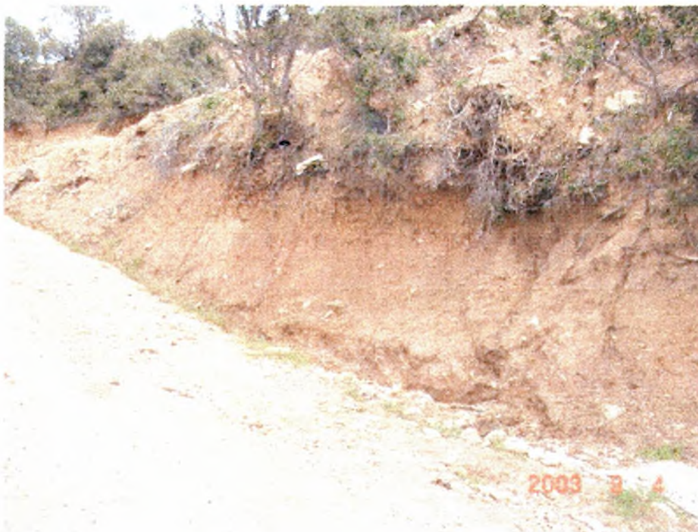
Φωτογραφία υλικών θεμελίωσης
