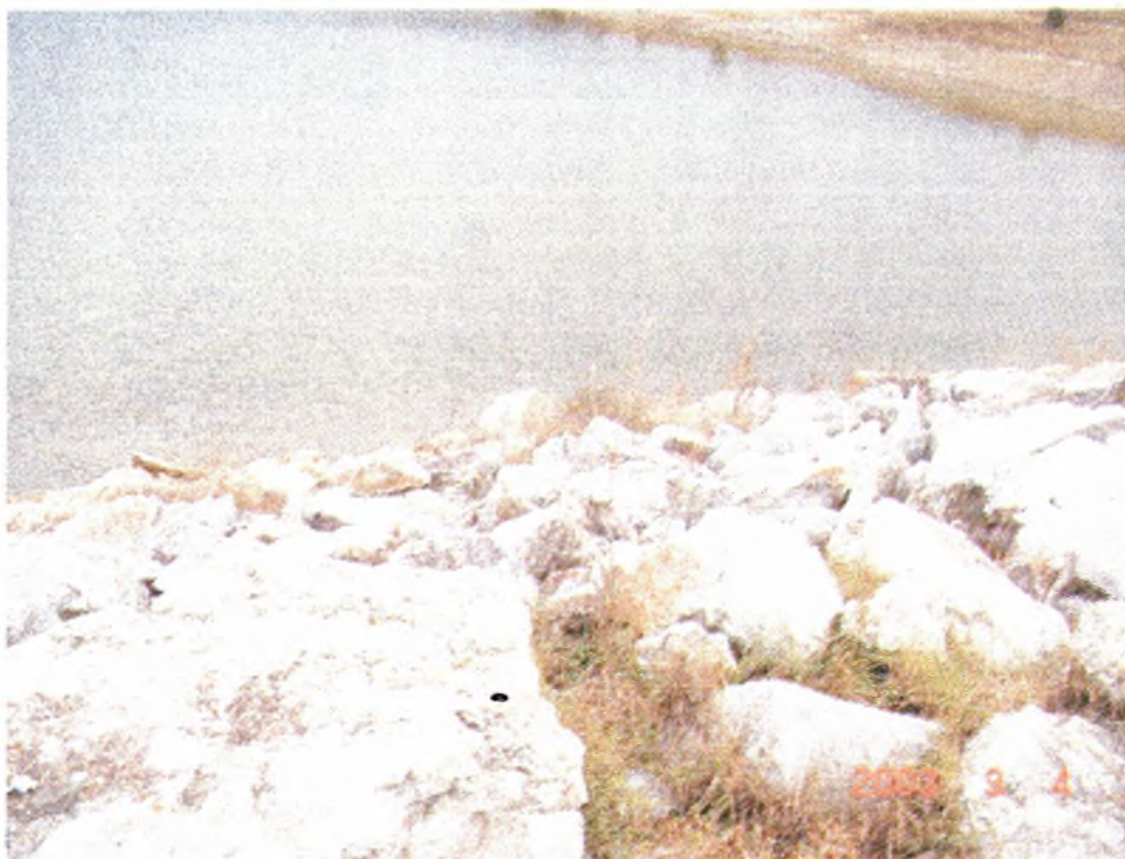
Στη φωτογραφία φαίνεται το υλικό λιθορριπής που τοποθετήθηκε ανάντη του ταμιευτήρα.
