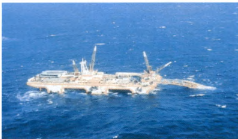
ΣΧΗΜΑ 1-1: Η ημιβυθισμένη φορτηγίδα Viking Piper (semi-sumbergible barge) κατά την διάρκεια της πρώτης επιχείρησης τοποθέτησης υποθαλάσσιων αγωγών στην βόρεια θάλασσα. Πόντιση με την μέθοδο S-lay (Veldman and Laggers,1997)
