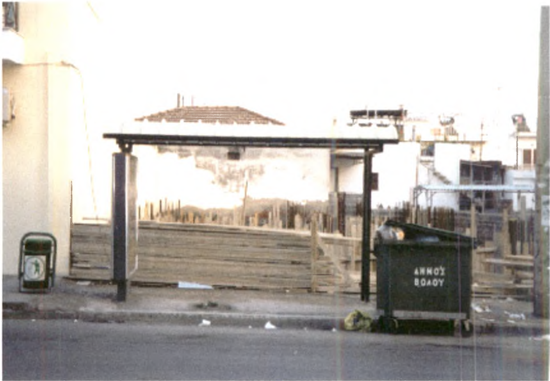
Φωτογραφία 7: Στάση με στέγαστρο στο κέντρο της πόλης του Βόλου (Ιωλκού)
