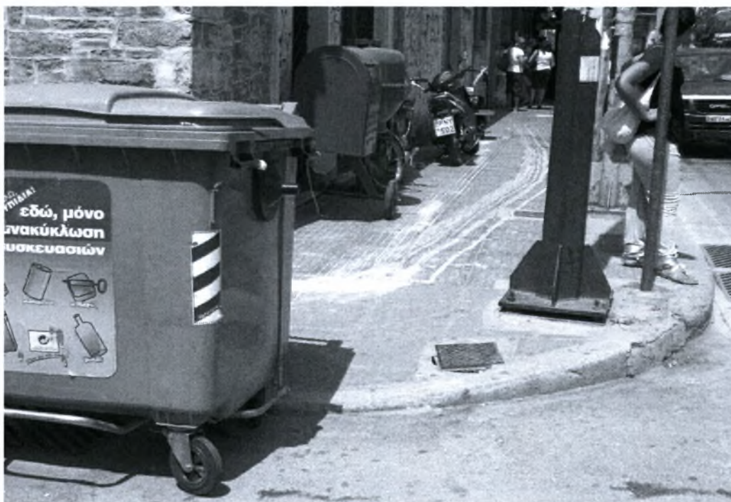
Φ1.8. Ο κάδος απορριμμάτων εμποδίζει τη χρήση της ράμπας δεξιά της στάσης
