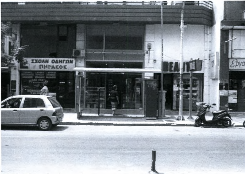
Φ2.3 Ο εξοπλισμός της στάσης – αυτόματος πωλητής εισιτηρίων, ηλεκτρονικός πίνακας ενημέρωσης δρομολογίων
