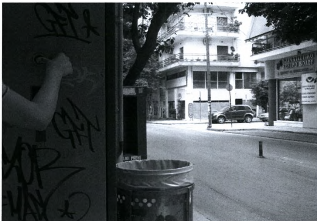
Φ.7.7. Ανεπαρκής ορατότητα από το υπόστεγο κυρίως λόγω της θέσης του αυτόματου πωλητή εισιτηρίων
