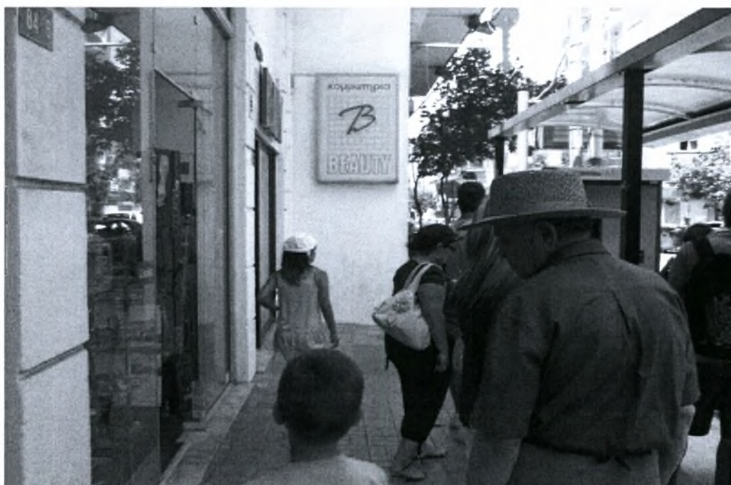
Φ2.2. Οι διαστάσεις του υποστέγου δεν ανταποκρίνονται στους υψηλούς κυκλοφοριακούς φόρτους των επιβατών
