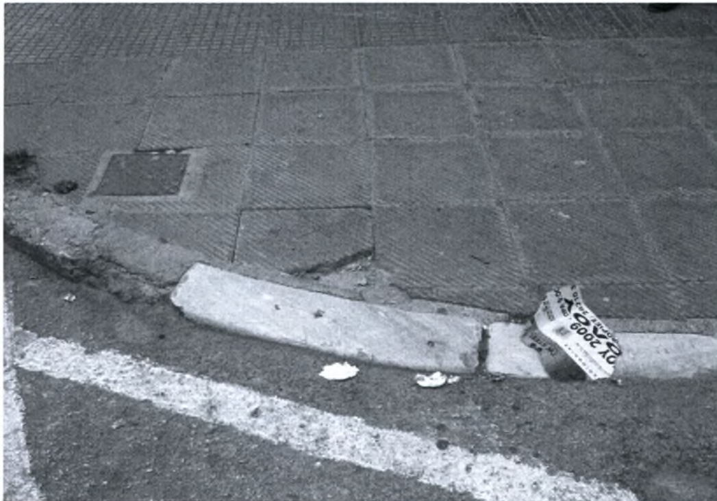
Φ1.7. Ανόμαλη επιφάνεια με σπασμένα πλακάκια στη ράμπα αριστερά της στάσης
