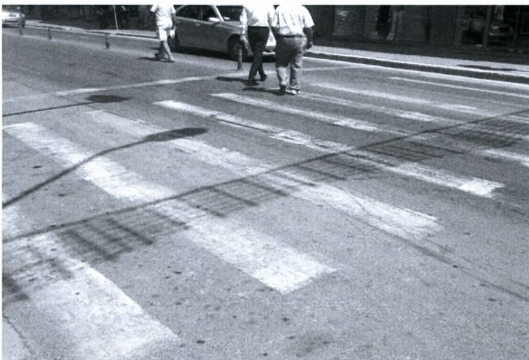
Φ3.4. Διαγραμμισμένη διάβαση στη διασταύρωση αριστερά της στάσης – ξεθωριασμένη (ένδειξη κακής συντήρησης)
