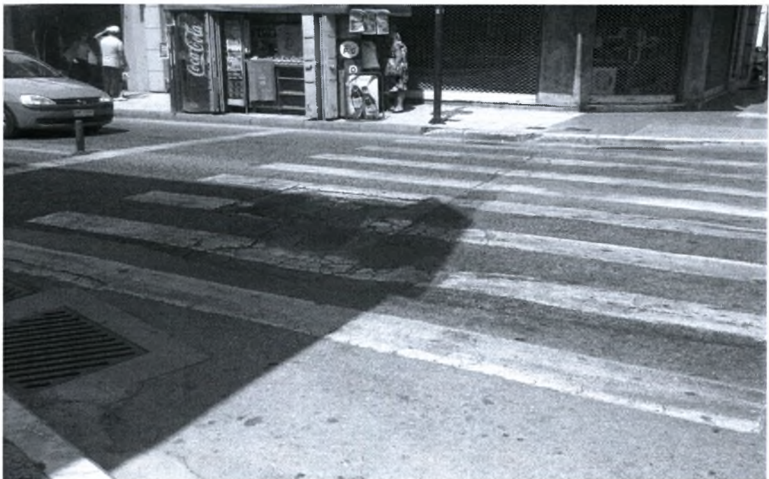
Φ4.4. Εεθωριασμένες διαβάσεις με σημαντικές φθορές
