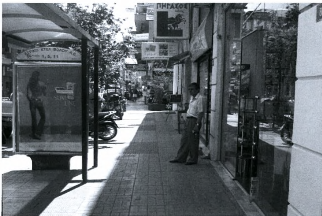
Φ2.1. Μεταλλικά καπάκια στην επιφάνεια του χώρου αναμονής – άμεση σύνδεση του χώρου αναμονής με το πεζοδρόμιο – εξυπηρέτηση των ΑΜΕΑ. λόγω απουσίας καθίσματος - ελεύθερος χώρος για τη διέλευση των πεζών
