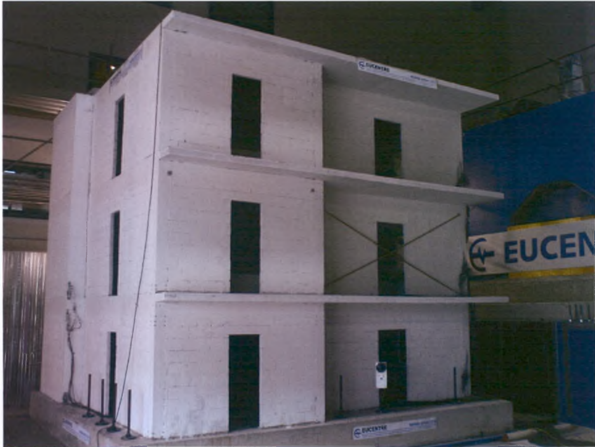
Εικόνα 2–1 Το κτίριο του πειράματος NEARB
