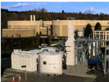
Σχήμα 2.8. Εργοστάσιο παραγωγής ισχύος με κυψέλες καυσίμου [26].
