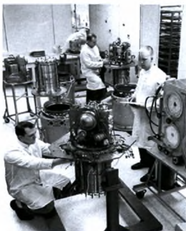
Σχήμα 2.29. Οι τεχνικοί της Pratt & Whitney συναρμολογούν τις αλκαλικές κυψελίδες για το Apollo [17].
