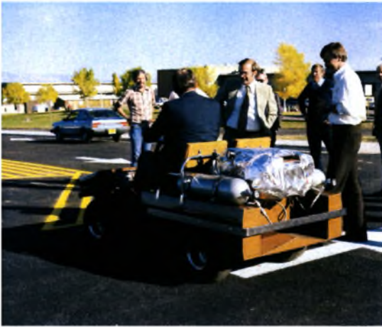
Σχήμα 2.24. Το πρώτο αμαξάκι του golf που τροφοδοτήθηκε από κυψέλες καυσίμου φωσφορικού οξέος, Los Alamos, 1970 [28].
