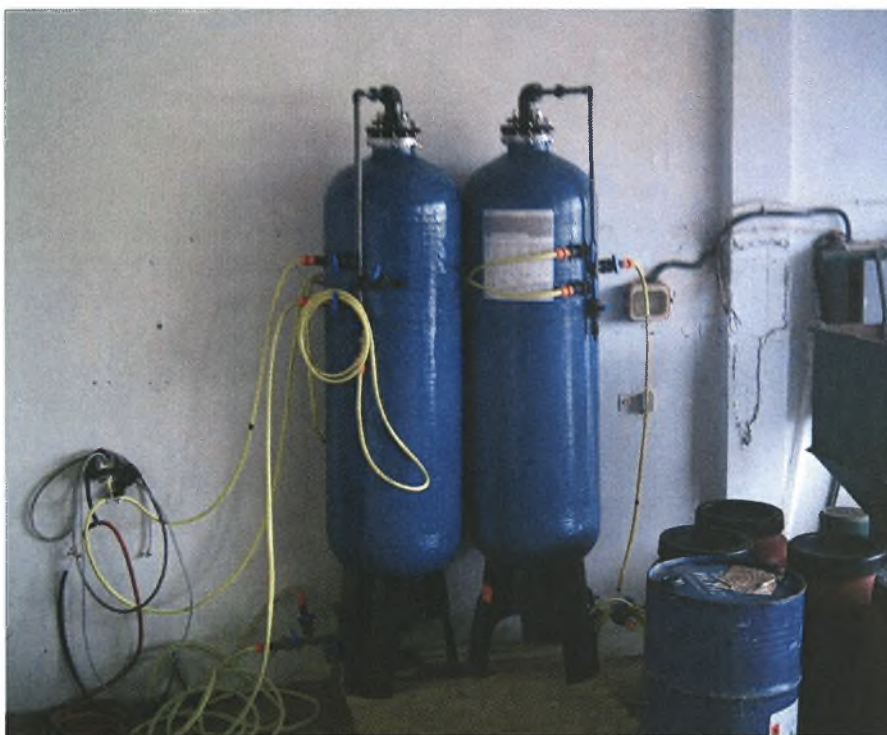
Εικόνα 5. Στήλη ύψους 160 cm και διαμέτρου 40 cm η οποία έχει πληρωθεί με 100 Lt προσροφητικής ρητίνης.
