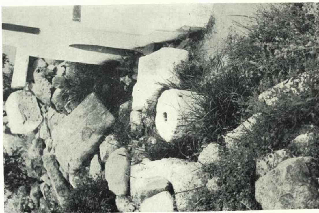
α. Αρχιτεκτονικά μέλη παρά την βόρειον πλευράν του εικονοστασίου.
