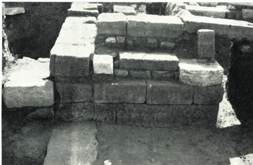
β. Νοτία πλευρά τῆς δυτικῆς πύλης. Ἀριστερὰ πλίνθος μετὰ τόρμου διὰ τὴν ὑποδοχὴν τοῦ ληνοῦ τῆς θύρας.
