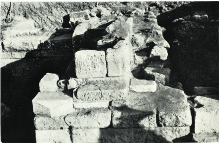
β. Λεπτομέρεια κατασκευῆς τοῦ τείχους βορείως τῆς δυτικῆς πύλης.
