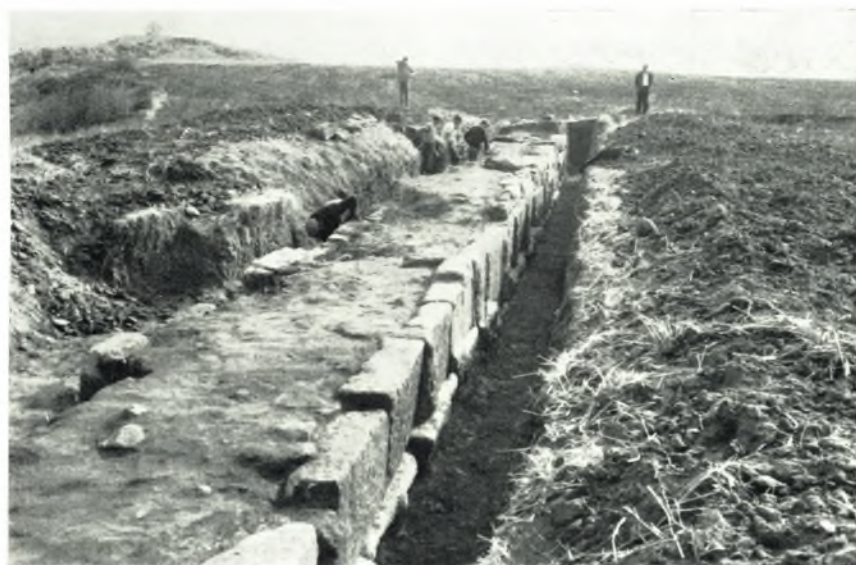
β. Ἐσωτερικὴ πλευρὰ τοῦ παραθαλασίου τείχους. Ἐπομῆς ἐξ Ἀνατολῶν πρὸς Δυσμᾶς.
