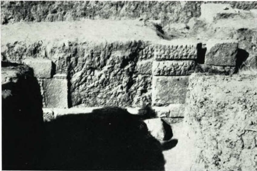
α. Κενόν ἐπὶ τῆς προσόψεως τοῦ τείχους διὰ τὴν προσαρμογὴν τοῦ ἀνατολικοῦ τοίχου τοῦ πύργου. Κάτω δεξιὰ, πλίνθος εὐθυνηρίας. *Αποφίς ἀπὸ Νότου.
