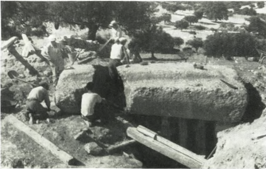
β. Ἀνώφλιον τοῦ τ. 1 κατὰ τὴν διάνοξιν τῆς ρωγμῆς ὑπὸ τῆς Ὑπηρεσίας Ἀναστηλώσεως.
