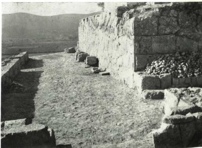
γ. Ὁ ἀνατολικὸς διάδρομος Ζαθ, ὁρῶμενος ἀπὸ τοῦ δωματίου θ. Δεξιᾶ ἡ πύλη Ζ καὶ ὁ λιθoσωρός.
