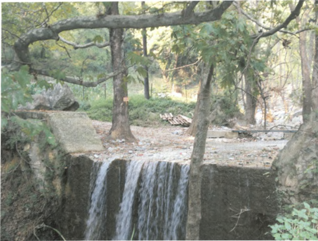
Εικόνα 21. Φράγμα του χειμάρρου Κραυσίδανα στην περιοχή Αγ. Ονούφριου
