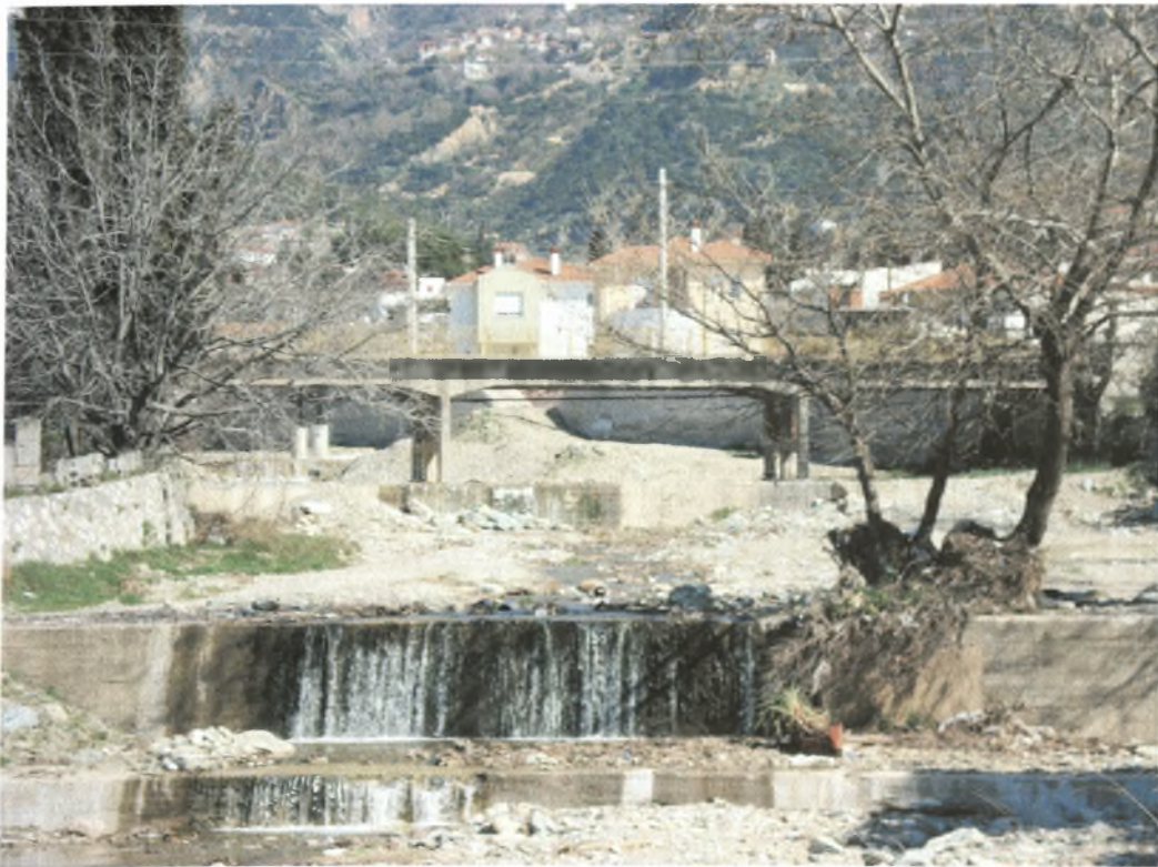
Εικόνα 22. Φράγμα του χειμάρρου Κραυσίδανα στην περιοχή Αγ. Παρασκευής
