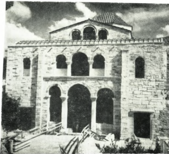
β. Ἡ πρόσοψις τῆς Καταπολιανῆς μετὰ τὰς ἐργασίας ἀναπαλαιώσεως.
