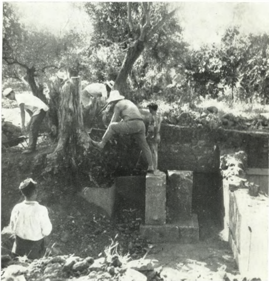
Ἡ ἀποκοπή τῶν μεγάλων δένδρων, ἅτινα εἶχον ἀναπτυχθῆ ἐπὶ τῆς ἐπιχώσεως τοῦ παραπλεύρως τοῦ ναοῦ τῆς Ἀρτέμιδος διαμερίσματος Μ.
