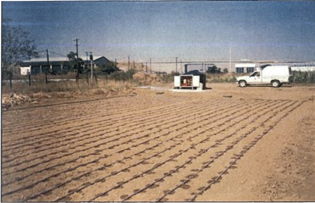
Εικόνα 2.5 Έλεγχος λειτουργίας του αρδευτικού συστήματος
