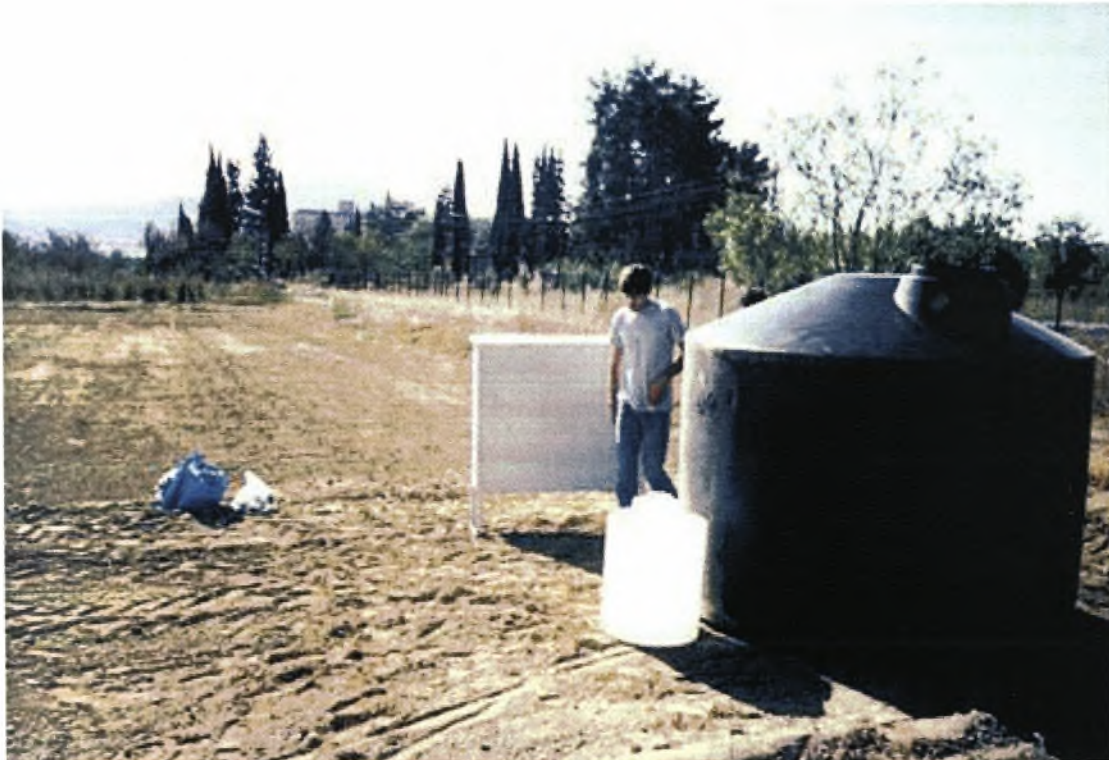
Εικόνα 2.2 Τοποθέτηση της πλαστικής δεξαμενής
