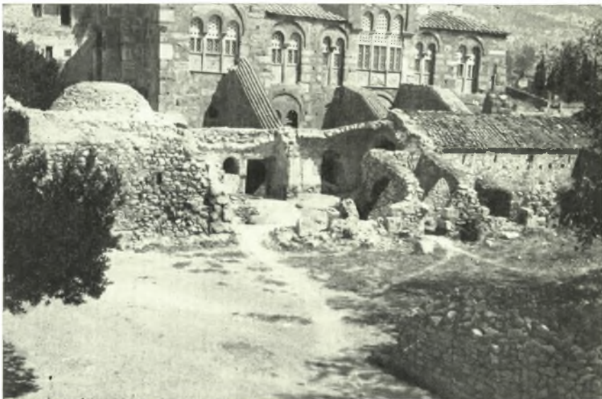
β. Ἡ Τράπεζα τῆς Μονῆς Ὁσίου Λουκά κατὰ τὴν ἔναρξιν τῶν ἐργασιῶν ἀναστηλώσεως αὐτῆς.
