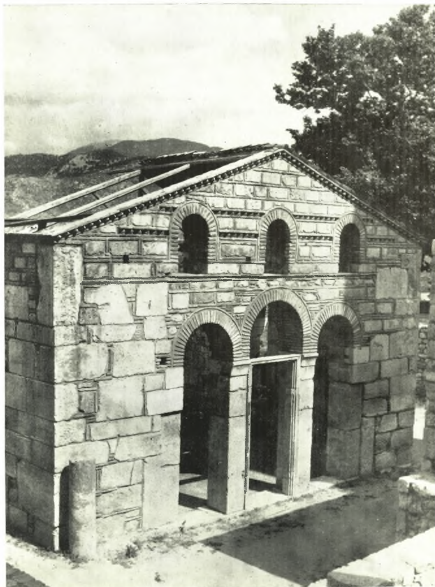
"Αποψις τῆς Τραπέζης ἀπὸ ΒΔ. μετὰ τὰς ἐργασίας ἀναστηλώσεως.
