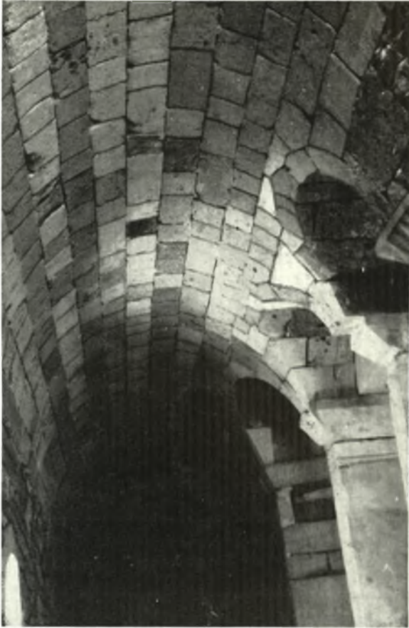
α. Ὁ αναστηλωθεὶς κυλινδρικός θόλος τοῦ νοτίου κλίτους τοῦ βαπτιστηρίου τῆς Καταπολιανῆς Πύρου.
