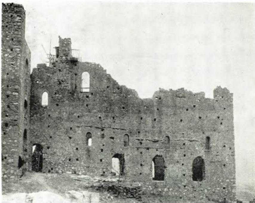
α. Ἡ νοτιὰ πλευρὰ τοῦ ἀνακτόρου τῶν Καντακουζηνῶν εἰς τὸν Μυστράν, πρὸ τῶν ἐργασιῶν τοῦ 1964.
