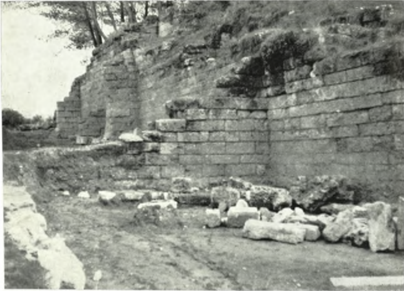
α. Όπισ τῶν ἰσοδόμῳς ἐκτισμένων ἀντηρίδων τοῦ τοίχου τῆς νοτίας παρόδου.
