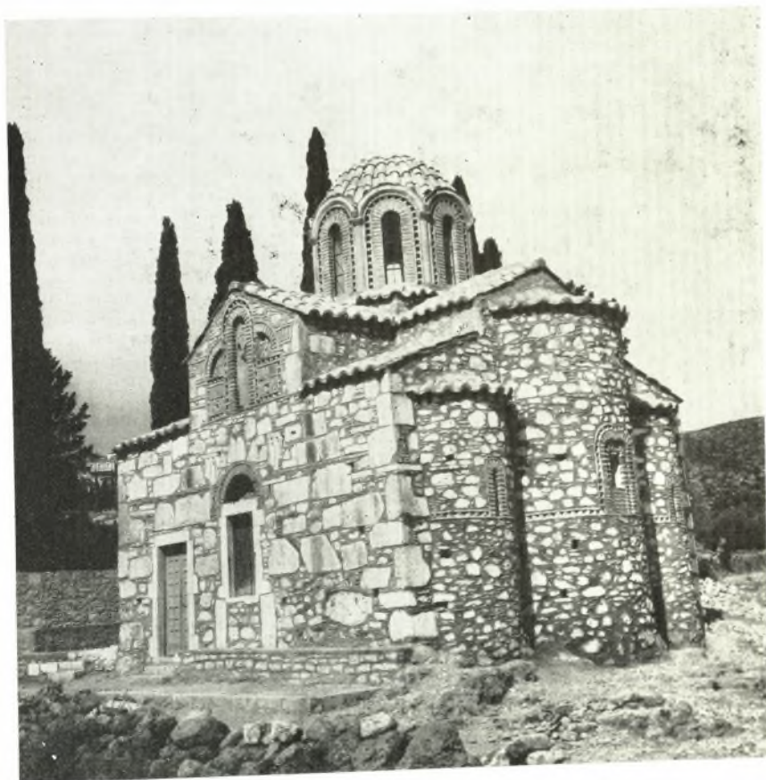
Ὁ ναὸς τοῦ Ἁγ. Ἀθανασίου εἰς Γεράκι μετὰ τὴν ἀφαίρεσιν τῶν μεταγενεστέρων κονιαμάτων τοῦ ἱεροῦ.
