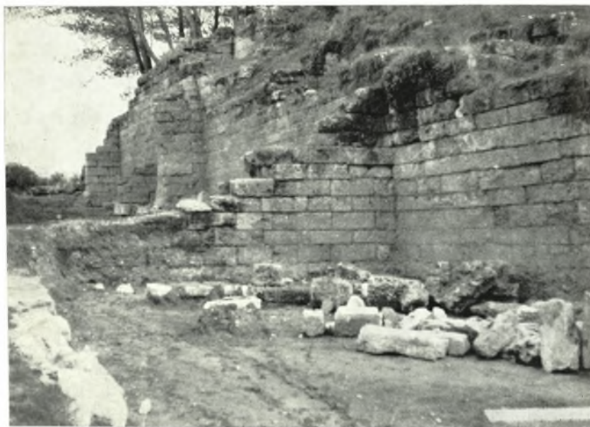
α. Όψεις τῶν ἰσοδόμους ἐκτισμένων ἀντηρίδων τοῦ τοίχου τῆς νοτίας παρόδου.
