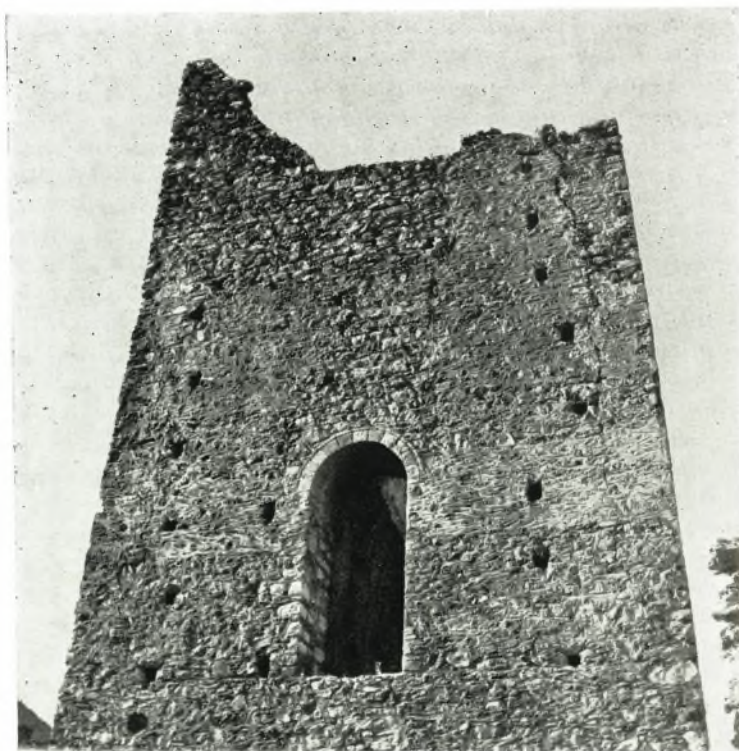
α. Ἡ ἀνατολική πλευρά τοῦ ἀνακτόρου τῶν Καντακουζηνῶν μετὰ τὰς ἐργασίας τοῦ 1964.
