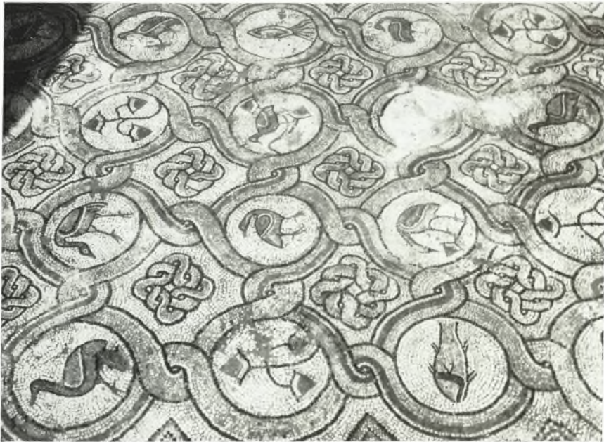
α - β. Στερεωθέν και όριζόντιωθέν τμήμα του ψηφιδωτού διαπέδου του νάρθηκος της βασιλικής Α της Νικοπόλεως.
