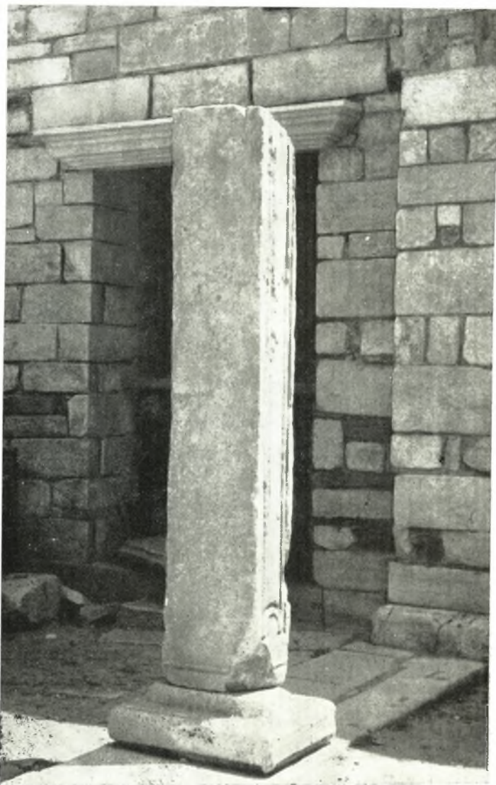
*Ο αναστηλωθείς ἐπὶ τῆς διασωθείσης βάσεως αὐτοῦ πρῶτος πεσσὸς τῆς βορείου πεσσοστοιχίας τοῦ αἰθρίου.
