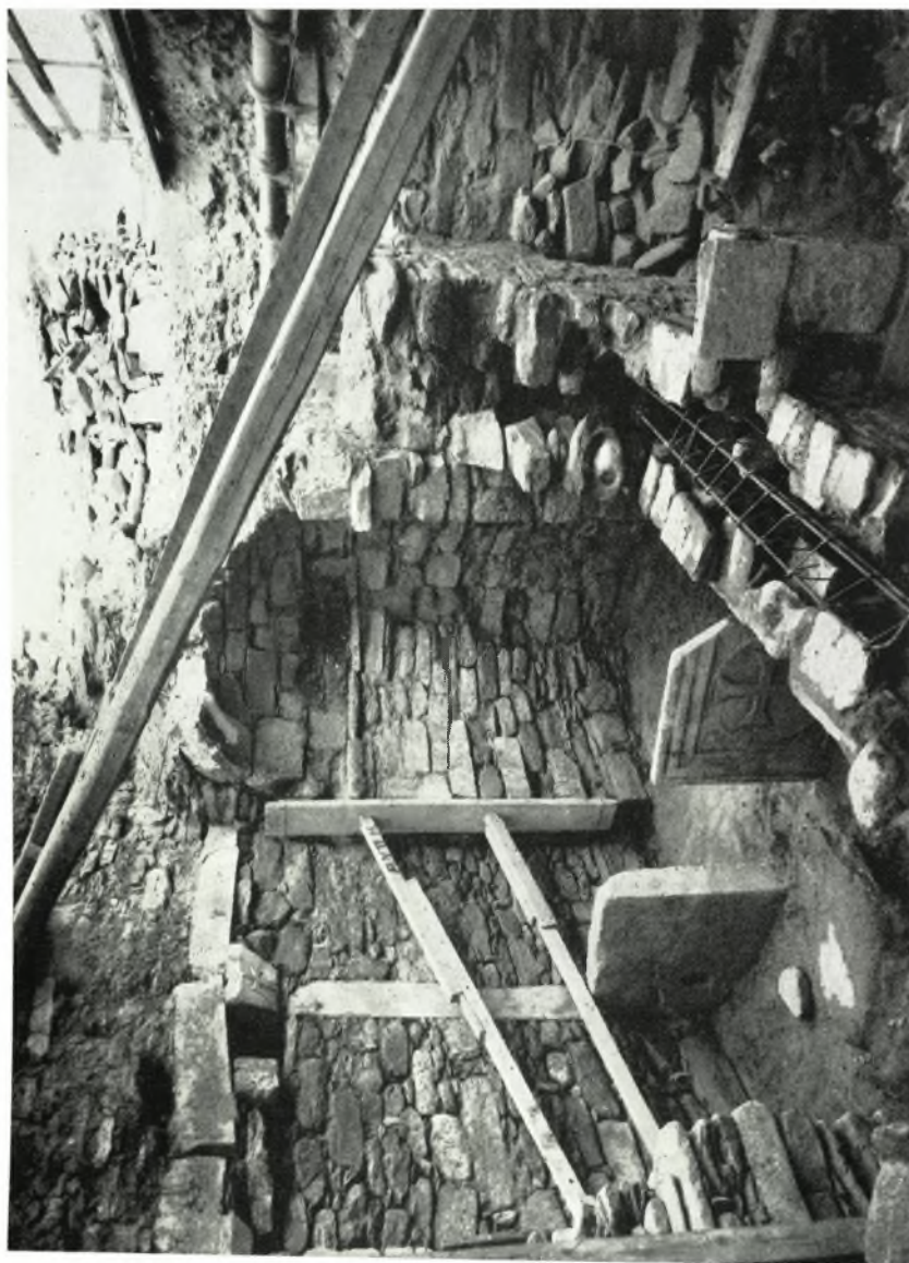
Τὸ νότιον κλίτος τοῦ βαπτιστηρίου πρὸ τῶν ἐργασιῶν ἀνακατασκευῆς τοῦ κυλινδρικοῦ θύλου του.
