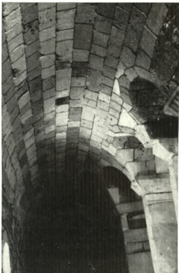
α. Ὁ αναστηλωθεὶς κυλινδρικός θόλος τοῦ νοτίου κλίτους τοῦ βαπτιστηρίου τῆς Καταπολιανῆς Πύλου.
