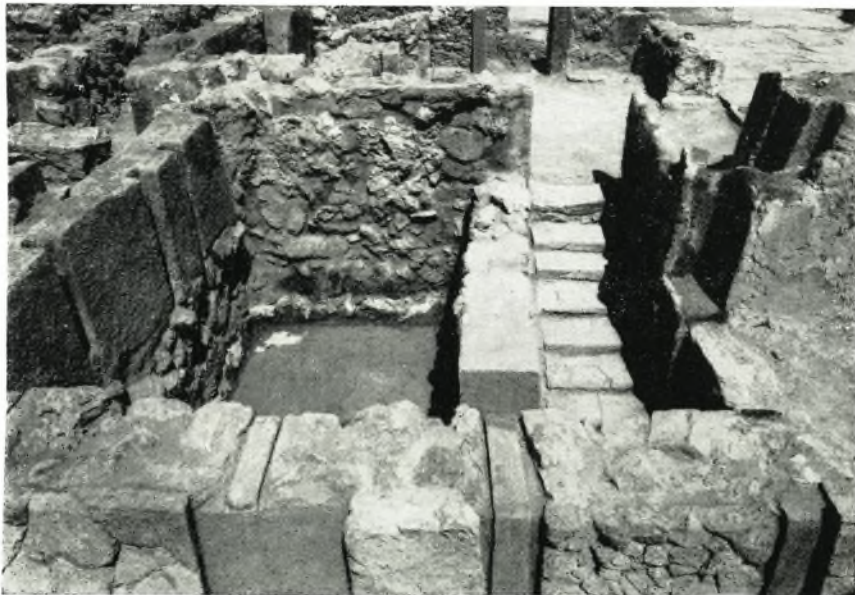
β. Ἡ καθαρήριος δεξαμενὴ (XXIV) τοῦ Ἱεροῦ μετὰ τὴν στερέωσιν καὶ ἀποκατάστασίν της.
