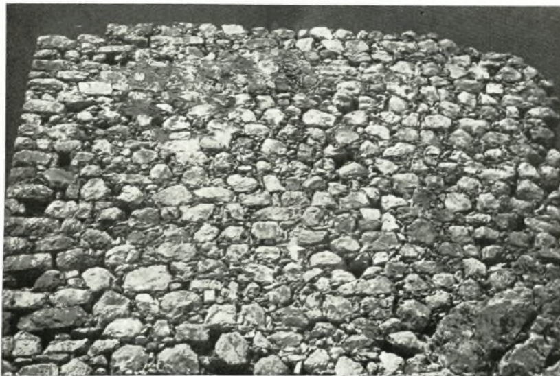
β. Τὸ κάστρον τοῦ ἀκρωτηρίου Τηγάνι. Τοιχοποιία τῆς Α. πλευρᾶς τοῦ παρὰ τὴν εἴσοδον πύργου.
