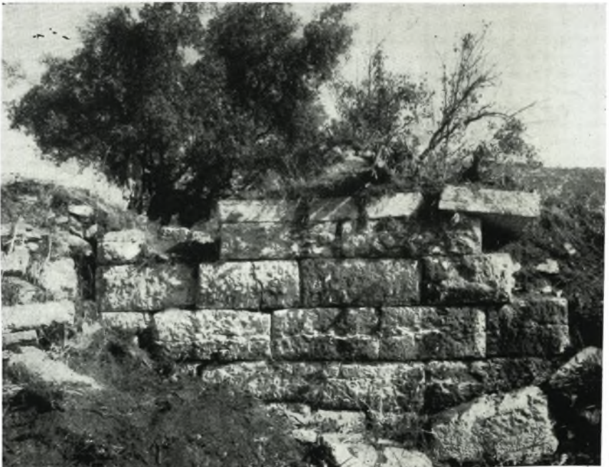
β, Όφεις τοῦ ἀναλήμματος τῆς ΝΔ. γωνίας τῆς «Ἀγορᾶς» μετὰ τὸν καθαρισμὸν του.
