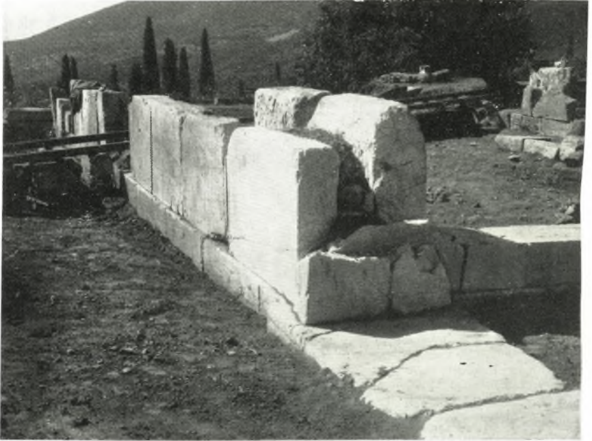
α. Όψις τῆς ἐξωτερικῆς παρειάς τοῦ διαμερίσματος Υ μετὰ τὴν ἀναστήλωσιν τῶν ὀρθοστατῶν.
