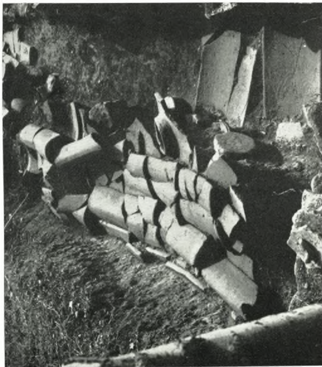
α. Μέρος κατασκευῆς στέγης.
