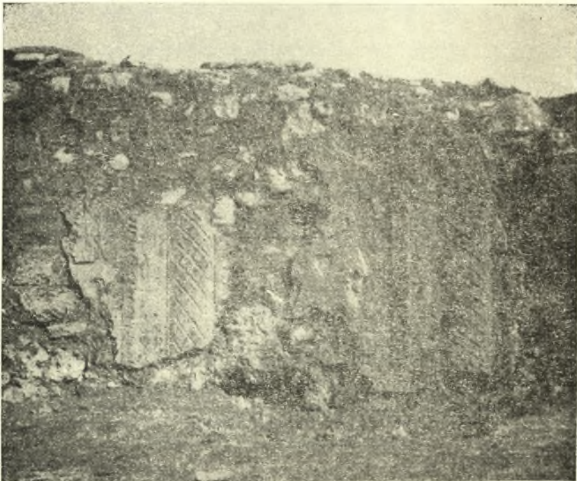
Εἰκ. 26. Ὑπόστρωμα ἐκ κονιάματος τῶν γυψίνων παραστάδων τοῦ βαπτιστηρίου.
