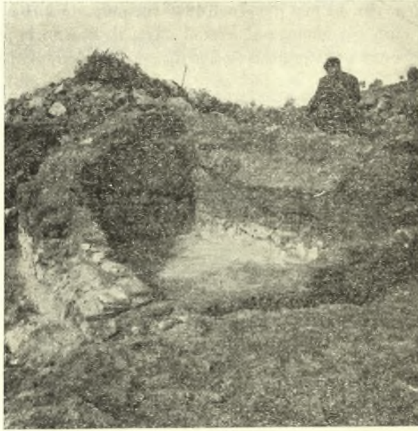
Εἰκ. 25. Ἀποψις τῆς θολωτῆς δεξαμενῆς ἀπ' ἀνατολῶν.
